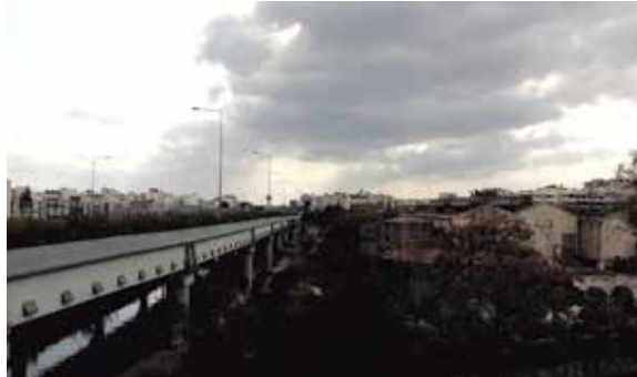
Κηφισός - Εθν. οδός - ΑΗΣ Νέου Φαλήρου
