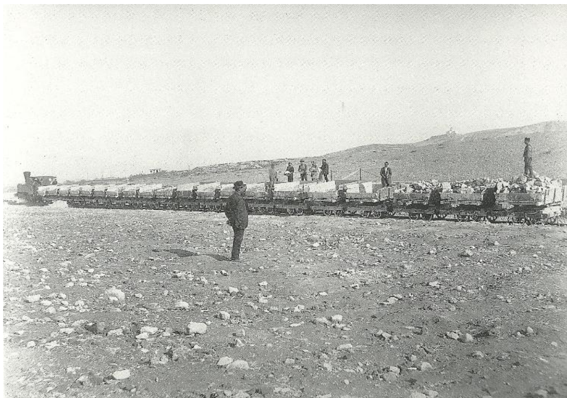
Αμαξοστοιχία έργων κατασκευής της πρώτης ελληνικής σιδηροδρομικής γραμμής Αθηνών – Πειραιώς κοντά στα Πετράλωνα. Δεξιά στο βάθος το Αστεροσκοπείο.
