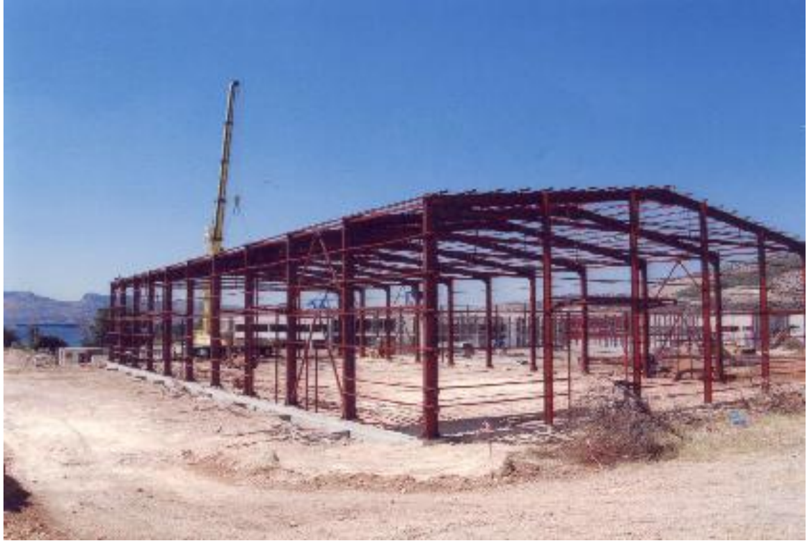
Όψη κτιριακής μεταλλικής εγκατάστασης κατά την κατασκευής
