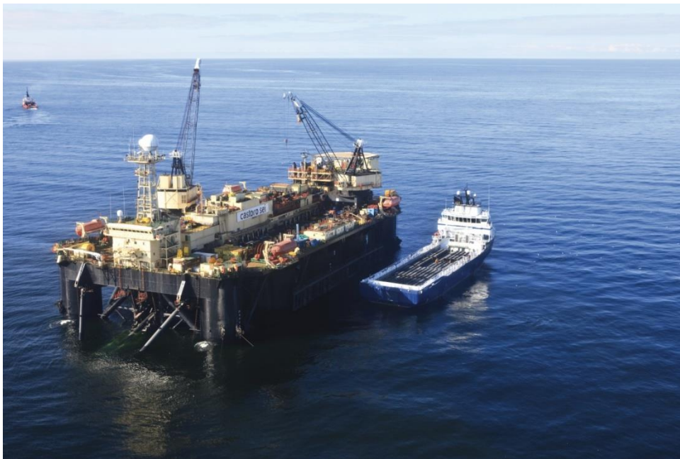
Εικόνα 3.11: Πλατφόρμα τοποθέτησης υποθαλάσσιων αγωγών «Castoro Sei». (Πηγή: www.nord-stream.com )
