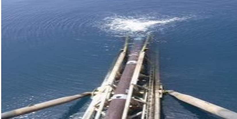
Εικόνα 3.6: Stinger: για τον έλεγχο και την σωστή καθοδήγηση του αγωγού προς το σημείο επαφής με τον πυθμένα της θάλασσας. (Πηγή: www.ringzone.com )
