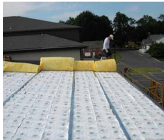
Σχήμα 8.5.19 Εφαρμογή BioPCM σε τοίχο (αριστερά) και οροφή (δεξιά) [73]
