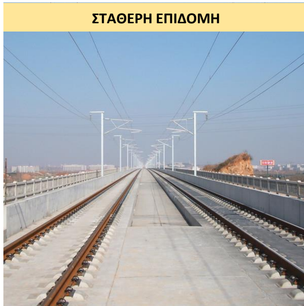
Σχήμα 9.6: Σταθερή επιδομή με διμερείς στρωτήρες (Μετρό Αθηνών)
