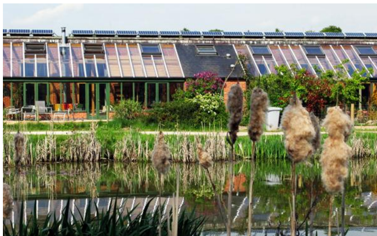
Εικόνα 2.8. Η νότια όψη των κατοικιών με το ηλιακό θερμοκήπιο
