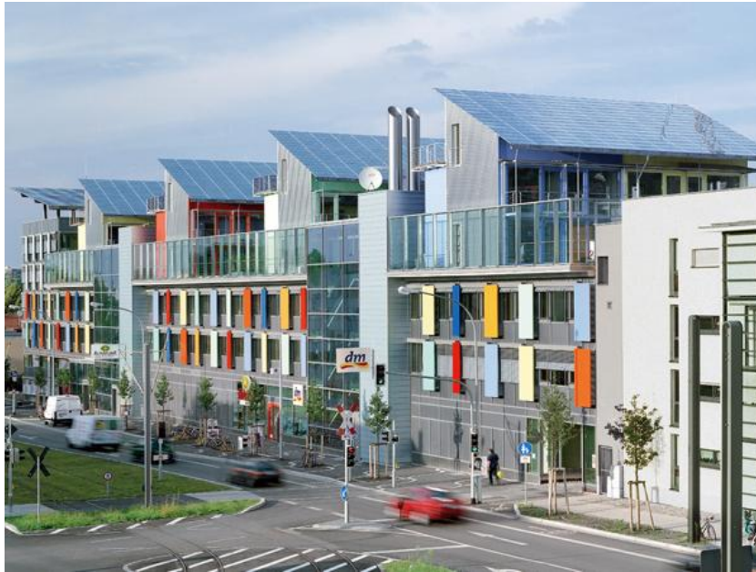
Εικόνα 2.10. Το κτήριο μικτών χρήσεων με τις εκτεταμένες γυάλινες επιφάνειες, τις αιολικές καμινάδες για τον φυσικό δροσισμό και αερισμό, και τα φωτοβολταϊκά συστήματα [20]
