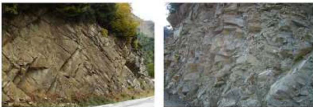
Σχήμα 4 Διακλάσεις που αποκαλύπτονται στις επιφάνειες βραχωδών πρανών
