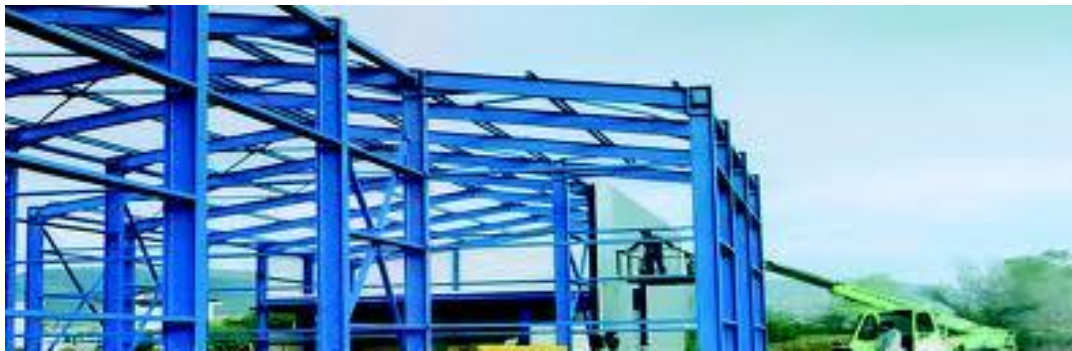
Αμιγώς Μεταλλικό Κτήριο
