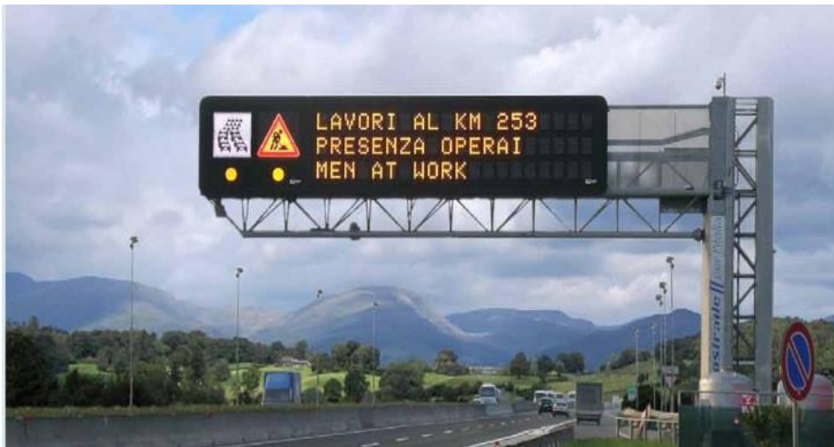
Σχήμα 2.1: Σταθερή Πινακίδα Μεταβλητών Μηνυμάτων (Πηγή: https://www.electroautomation.com )
