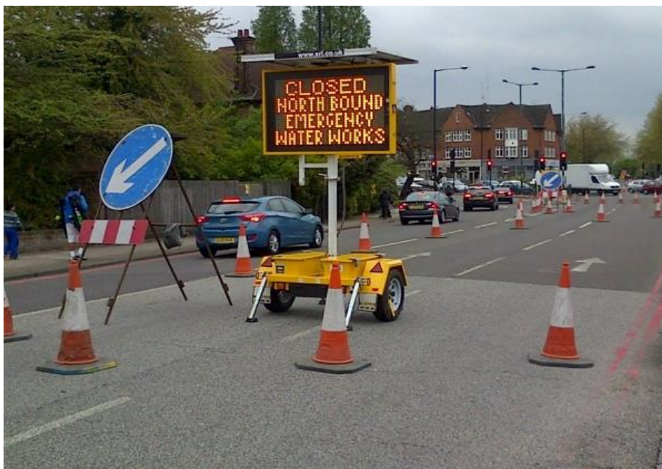
Σχήμα 2.2: Φορητή Πινακίδα Μεταβλητών Μηνυμάτων (Πηγή: http://www.srl.co.uk )
