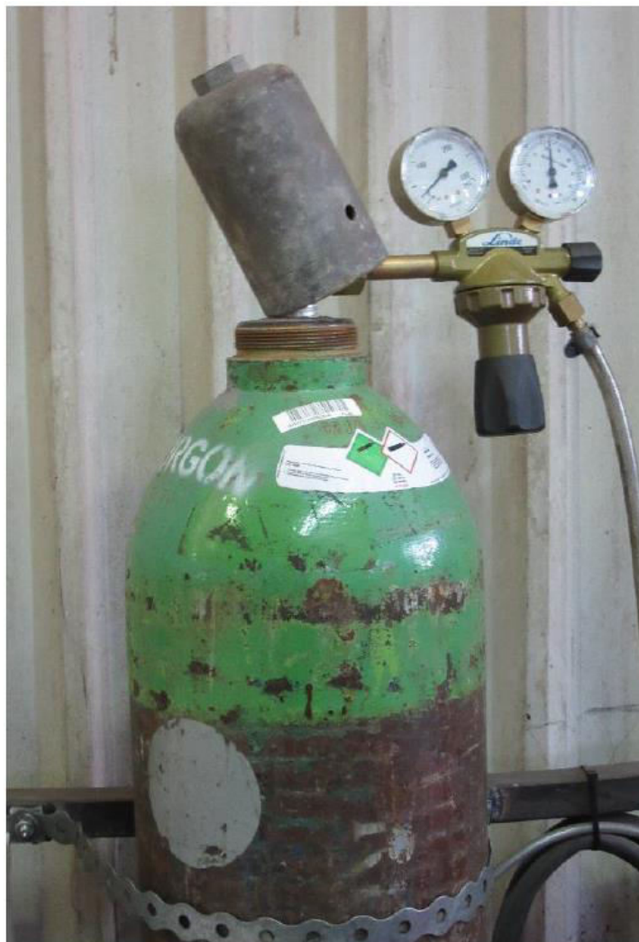
Εικ. 3.13 Φιάλη μείγματος αερίου προστασίας της συγκολλητικής διάταξης. Διακρίνεται ο ρυθμιστής πίεσης που ελέγχει την παροχή του αερίου
