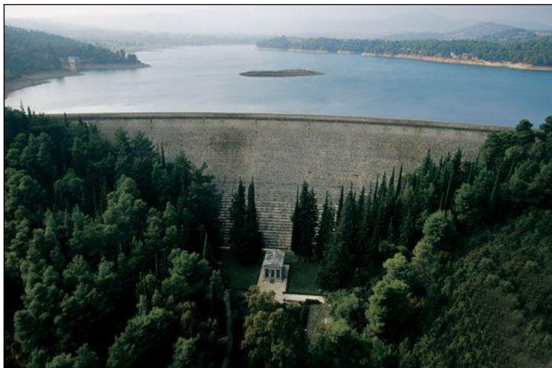
Σχήμα 1.4.1 Το φράγμα του Μαραθώνα (Φωτογραφικό αρχείο ΕΥΔΑΠ).
