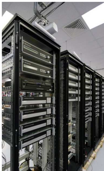
Εικόνα 5. Σύστημα δημόσιων ανακοινώσεων που αποτελείται από ενισχυτές, μείκτες και δρομολογητές.
