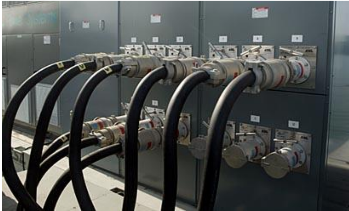
Σχήμα 2.5. Παρουσιάζεται η εγκατάσταση υποδοχής πάνω στο πλοίο των καλωδίων τροφοδοσίας
