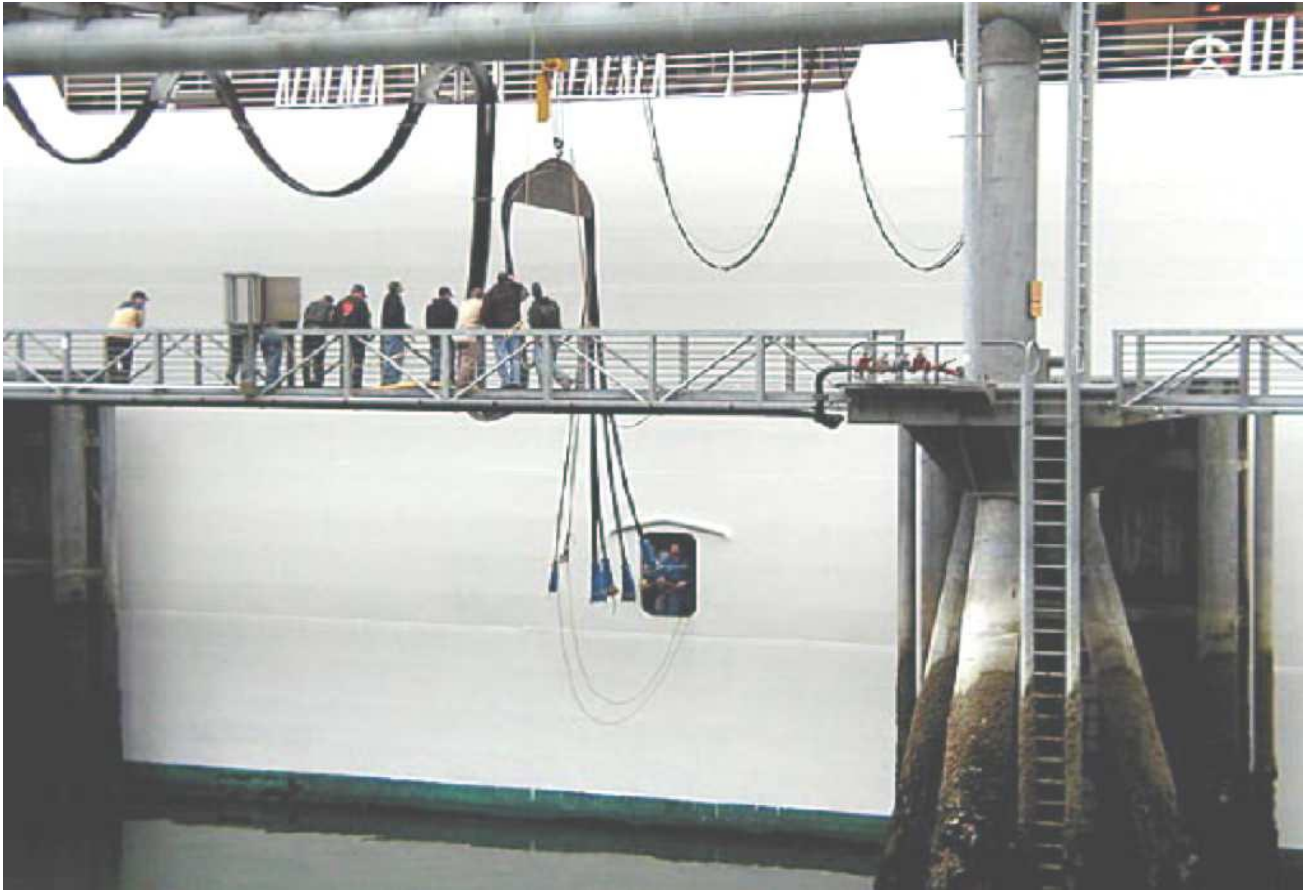
Σχήμα 2.6. Ανυψωμένα καλώδια κατά την διαδικασία μεταφοράς τους πάνω στο πλοίο
