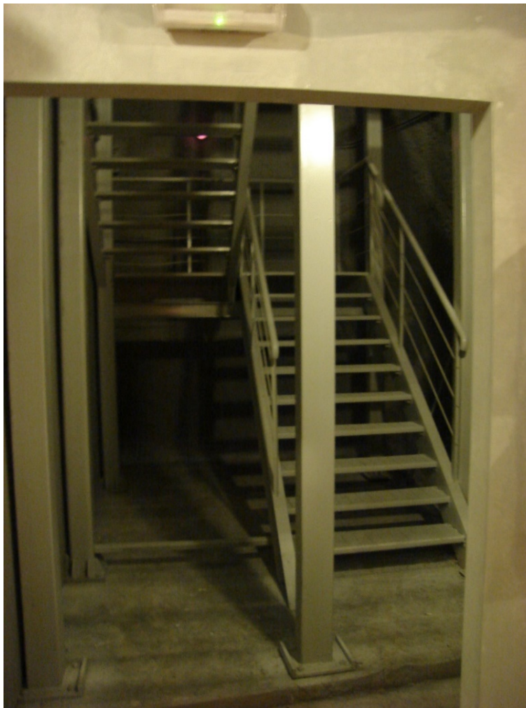
Εικόνα 31. Πόρτα κλιμακοστασίου του υπόγειου χώρου του Λαυρίου
