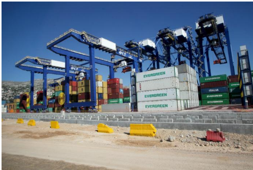
Εικόνα 3.2 Η κατασκευή της προβλήτας III
