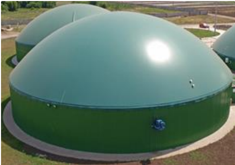
Εικόνα 5.10: Σύστημα κατακράτησης Βιοαερίου.
