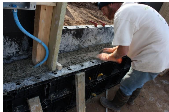
Εικόνα 15.: Απεικονίσεις κατασκευής οικίας Push House, (inhabitat.com).
