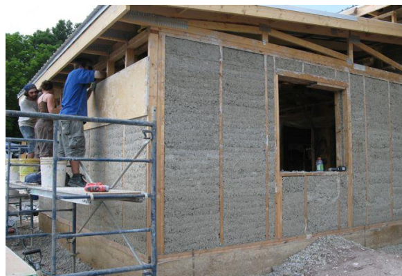
Εικόνα 3.: Συμπιεσμένη ασβεστοκάνναβη μετά την αφαίρεση των προσωρινών καλουπιών, ( http://www.greenbuildermedia.com ).
