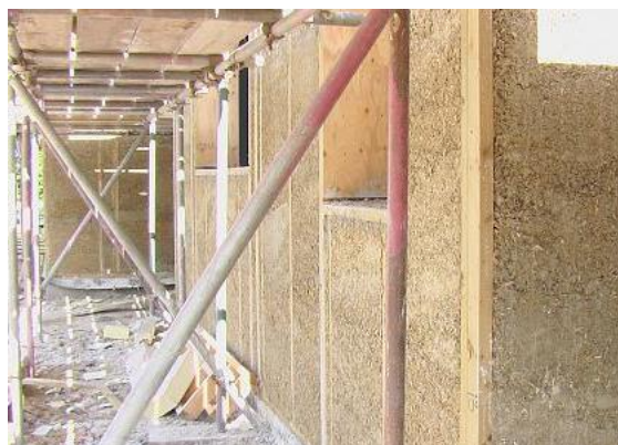
Εικόνα 2.: Συμπιεσμένη ασβεστοκάνναβη μετά την αφαίρεση των προσωρινών καλουπιών. ( http://www.weststructure.co.uk/ ).
