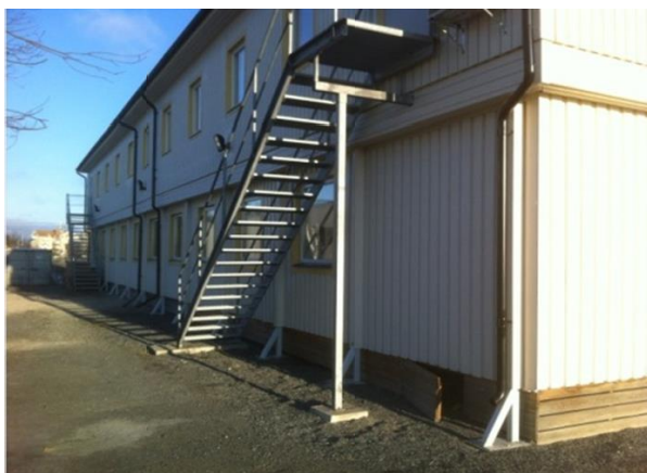
Εικόνα 18.: Αποκατάσταση του κτιρίου Runö στο Österåker, φθινόπωρο 2011, (Picture: R. Kilman)
