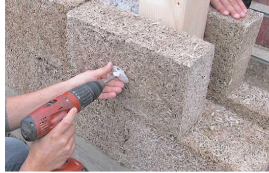
Εικόνα 7.: Κατασκευή με τούβλα από ασβεστοκάνναβη, ( www.420magazine.com ).
