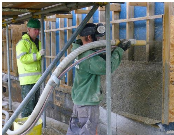
Εικόνα 4.: Μέθοδος ψεκασμού ασβεστοκάνναβης, (www.kenderbetonhaz.hu).
