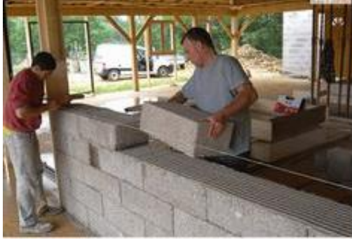
Εικόνα 6.: Κατασκευή με τούβλα από ασβεστοκάνναβη, ( chanvriblock.com ).
