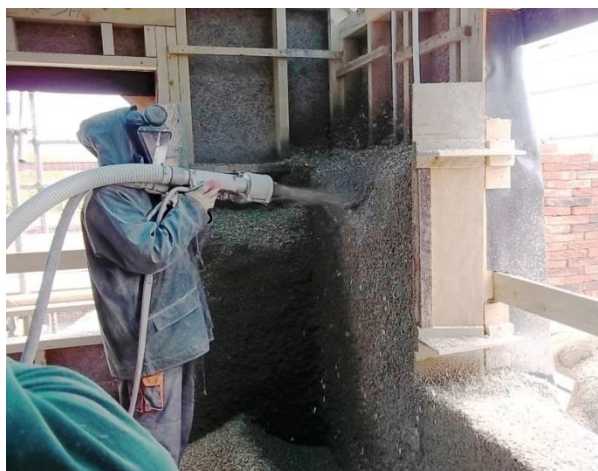
Εικόνα 5.: Μέθοδος ψεκασμού ασβεστοκάνναβης, (cannabisdigest.ca).
