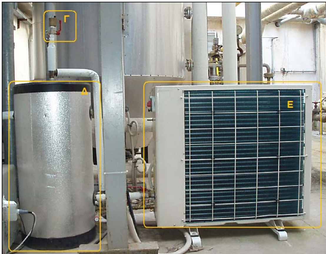
Σχήμα 3.29: (Γ) Αυτόματο εξαεριστικό με βάνα, (Δ) Δοχείο αδρανείας, (Ε) Αντλία θερμότητας
