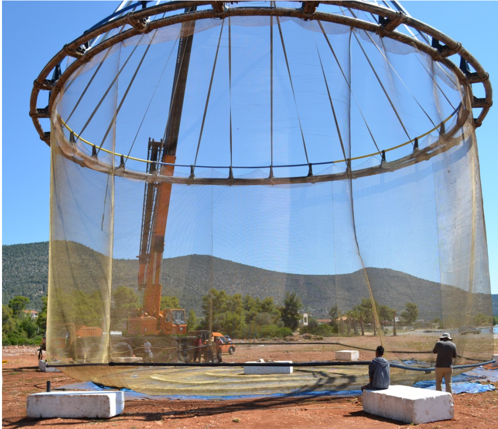
Εικόνα 1.1 Ιχθυοκλωβός με μεταλλικό δίχτυ (60m περίμετρο, 10m βάθος)
