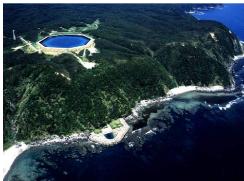
Σχήμα 5.4 Μονάδα αντλιοσταμείευσης στην Okinawa της Ιαπωνίας. Η θάλασσα παίζει τον ρόλο της κάτω δεξαμενής[9]
