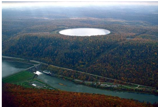
Σχήμα 5.3 Μονάδα αντλιοσταμείευσης στην Πενσυλβανία με συνολική εγκατεστημένη ισχύ 435 MW[9]
