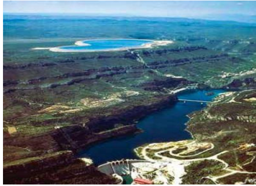
Σχήμα 5.2 Μονάδα αντλιοσταμείευσης (La Muela) στην Ισπανία με συνολική εγκατεστημένη ισχύ 635 MW. Αυτή τη στιγμή η μονάδα επεκτείνεται με την προσθήκη 852MW (La Muela 2) και αναμένεται να τεθεί σε λειτουργία το 2012[9]
