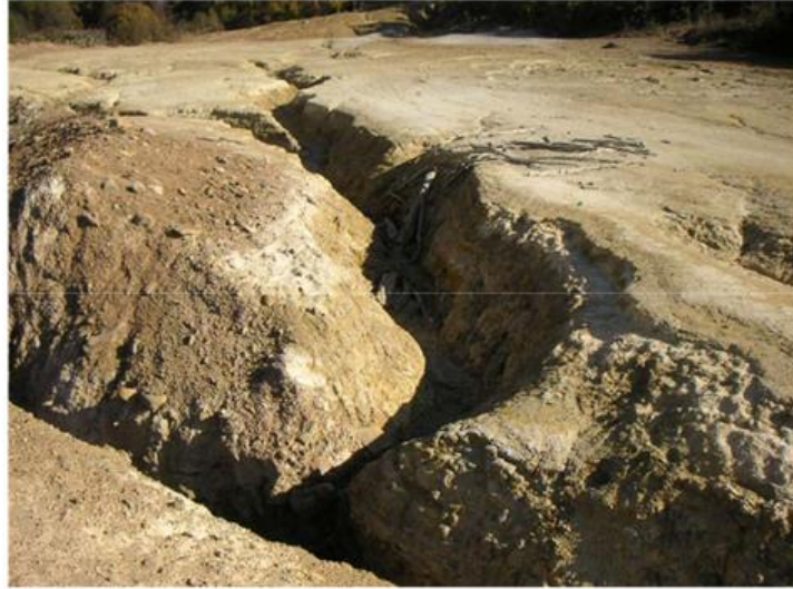
Εικόνα 3.10: Αυλακώσεις επί του αναχώματος στη λεκάνη 5. (Λουπασάκης & Κωνσταντοπούλου, 2007)
