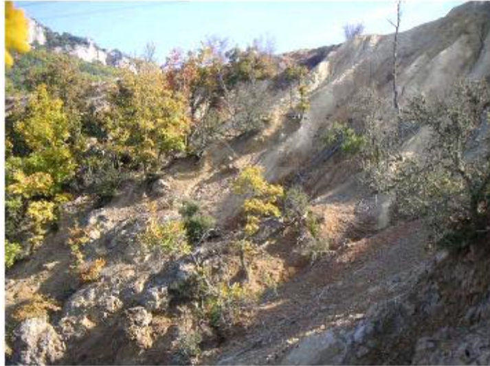
Εικόνα 3.6: Αυλακώσεις του εξωτερικού πρανούς της λεκάνης 3 λόγω των επιφανειακών απορροών και της υπερχείλησης του τέλματος. (Λουπασάκης & Κωνσταντοπούλου, 2007)
