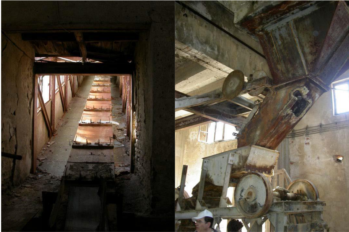
Εικόνες:2.6,2.7: Ταινιόδρομος μεταφοράς και σύστημα τροφοδοσίας του θραυστήρα. (Λιακοπουλος, 2009)
