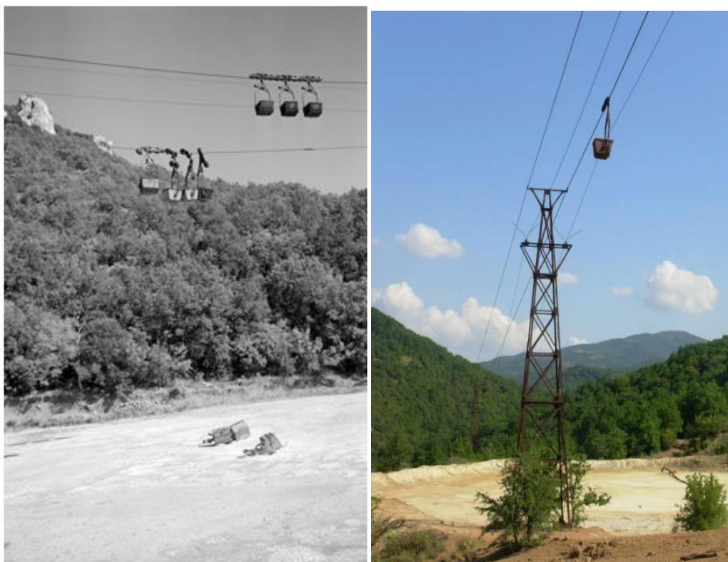
Εικόνες:1.12,1.13: Βαγονέτα του εναέριου σιδηρόδρομου, εν μέρει γκρεμισμένα στο έδαφος και τμήμα της διαδρομής. (Αρίκας et al., 2007), (Λιακοπουλος, 2009)
