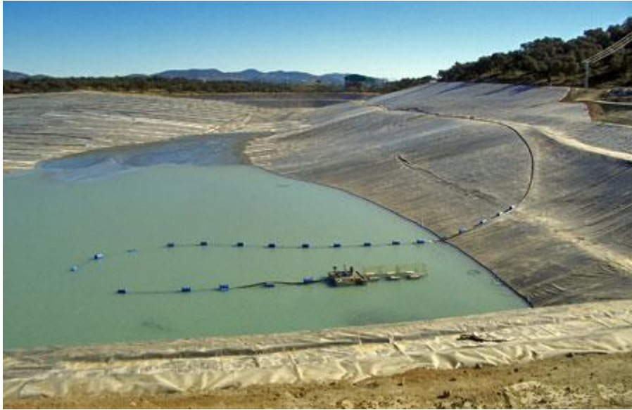
Εικόνα 2.18: Απόθεση κατά μήκος κοιλάδας. ( http://www.tailings.info/storage/containment.htm )
