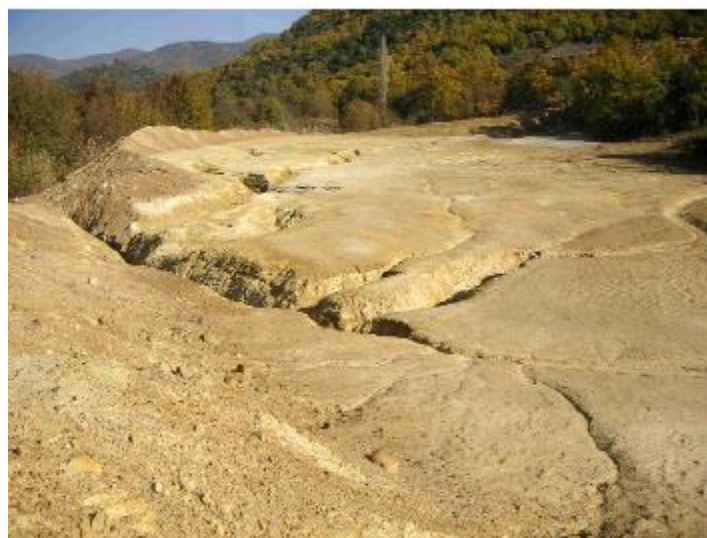
Εικόνα 3.9: Διαβρώσεις στο ανάχωμα της λεκάνης 5 από τις επιφανειακές απορροές. (Λουπασάκης & Κωνσταντοπούλου, 2007)
