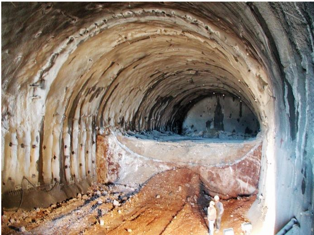
Εικόνα 3.15: Διάνοιξη σήραγγας σε δύο φάσεις (Marinos, 2019).
