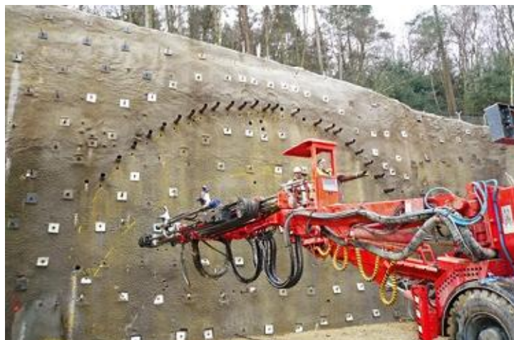
Εικόνα 3.14: Διάτρηση διατρημάτων για την τοποθέτηση τους (www.railsystem.net).
