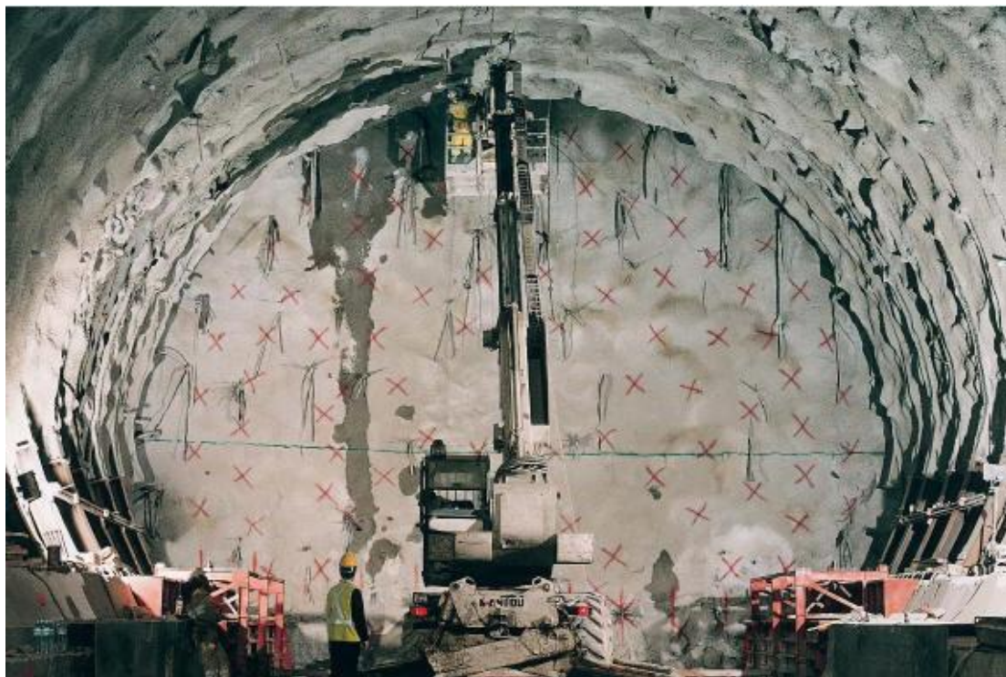
Εικόνα 3.10: Νέος γύρος τοποθέτησης ήλων μετώπου από υαλονήματα (Σοφιανός, 2015).
