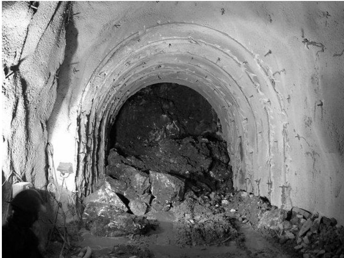
Εικόνα 3.4: Κατάρρευση μετώπου στοάς σε μεταλλείο στην Βόρεια Ελλάδα (Βλαχόπουλος, 2014).
