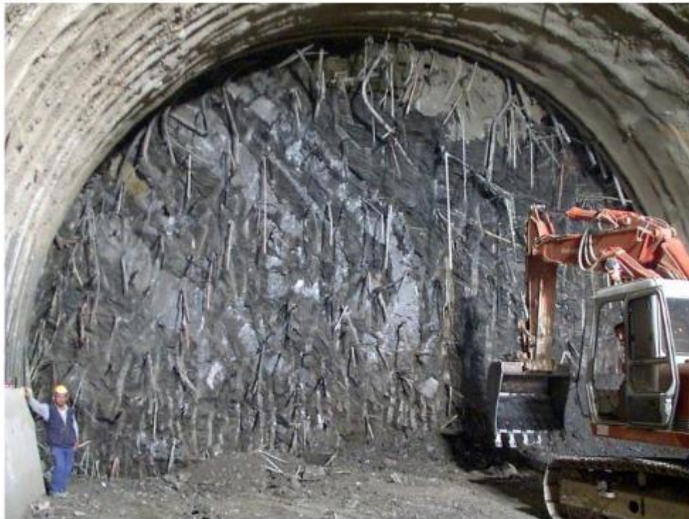
Εικόνα 3.6: Αποψη μετώπου ενισχυμένο με αγκύρια από υαλονήματα (fiberglass), (Lunardi, 2000).
