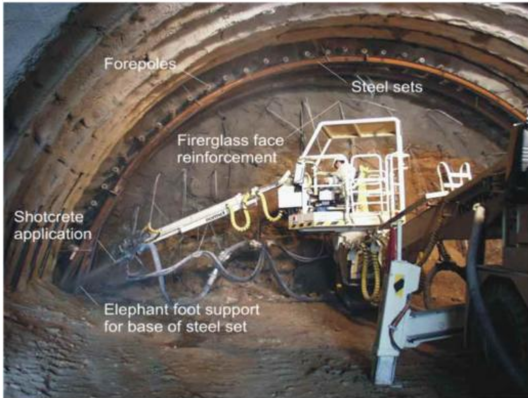
Εικόνα 3.13: Σκυροδέτηση έδρασης πλαισίου κάτω από την προστασία νέας σειράς δοκών προπορείας και ήλων μετώπου (Hoek, 2001).
