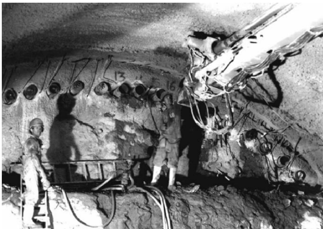
Εικόνα 3.12: Τοποθέτηση δοκών προπορείας στο Μετρό της Αθήνας (Αναγνώστου, 1997).
