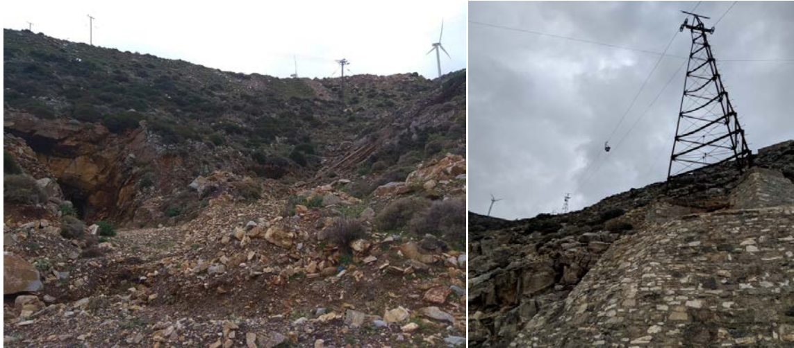
Εικόνα 6.12: Πρώτο ορυχείο της περιοχής "ο Παλιομητατος" (αριστερά), Πυλώνας 19 εναέριου σιδηρόδρομου (δεξιά)
