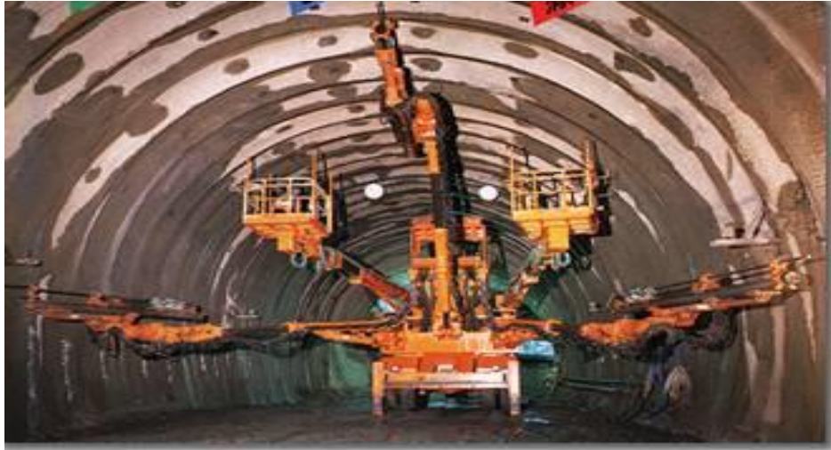
Σχήμα 2.12 : Μηχάνημα ψεκασμού Σκυροδέματος για την άμεση υποστήριξη της Σήραγγας (Πηγή : https://www.icm.co.jp/english/product/natm.html )
