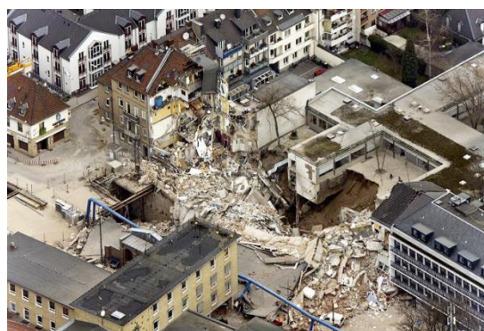
Εικόνα 1.2: Από αριστερά και δεξιόστροφα (α) Κατάρρευση τμήματος της επιφάνειας στη Λωζάννη λόγω των εργασιών του Metro. (Πηγή: https://randomwire.com/subterranean-danger/ ) (β) Κατάρρευση τμήματος του Metro της Κολωνίας λόγω μη σωστής Σχεδίασης της σήραγγας (Πηγή: https://www.tunneltalk.com/Cologne-collapse-Mar09-Deadly-collapse-in-Cologne.php )
