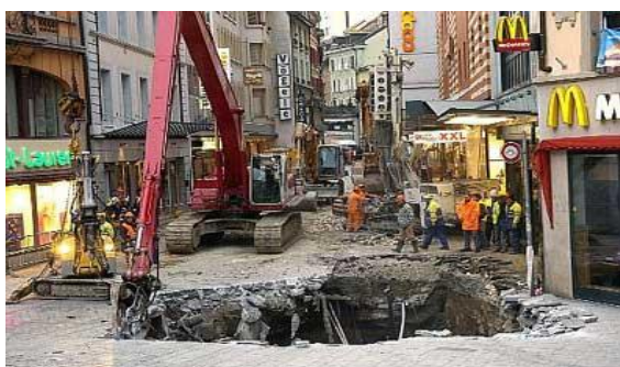
Εικόνα 1.2: Από αριστερά και δεξιόστροφα (α) Κατάρρευση τμήματος της επιφάνειας στη Λωζάννη λόγω των εργασιών του Metro. (Πηγή: https://randomwire.com/subterranean-danger/ ) (β) Κατάρρευση τμήματος του Metro της Κολωνίας λόγω μη σωστής Σχεδίασης της σήραγγας (Πηγή: https://www.tunneltalk.com/Cologne-collapse-Mar09-Deadly-collapse-in-Cologne.php )
