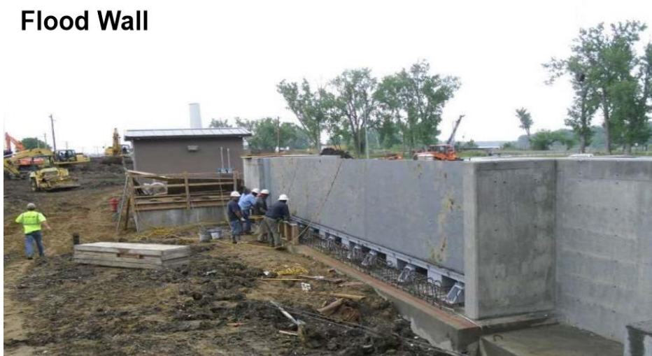
Εικόνα 3-8. Κατασκευή τοιχείου για αντιπλημμυρική προστασία (Protection of Water and Wastewater Treatment Plants with FEMA Funding Assistance(2016), Session D4, Chris Koenig, Senior Project Manager)
