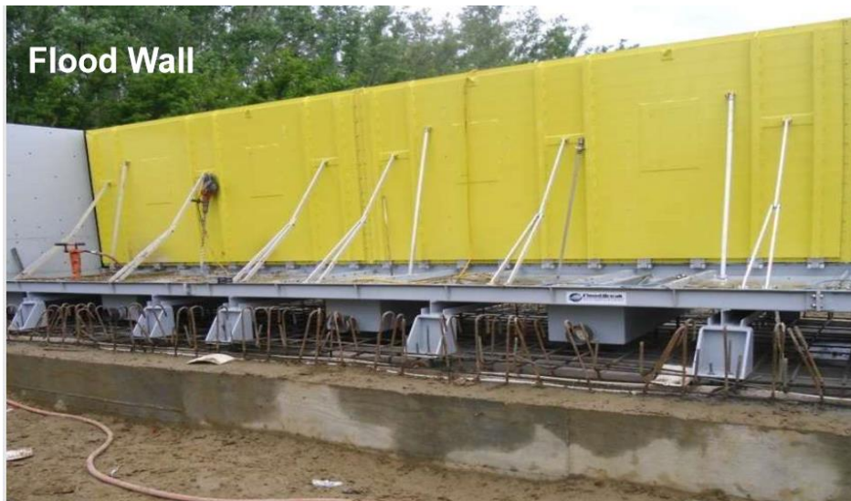
Εικόνα 3-7. Κατασκευή τοιχείου για αντιπλημμυρική προστασία (Protection of Water and Wastewater Treatment Plants with FEMA Funding Assistance(2016), Session D4, Chris Koenig, Senior Project Manager)
