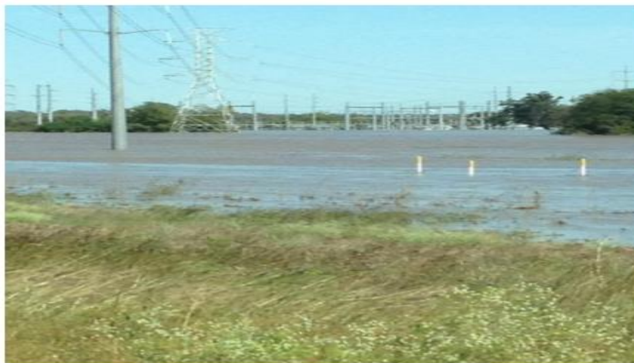
Εικόνα 3-3. Ο πλημμυρισμένος υποσταθμός Austin Energy (AE), Οκτώβριος του 2013 Τέξας (New York City Department of Environmental Protection, NYC Wastewater Resiliency Plan: Climate Risk Assessment and Adaptation)
