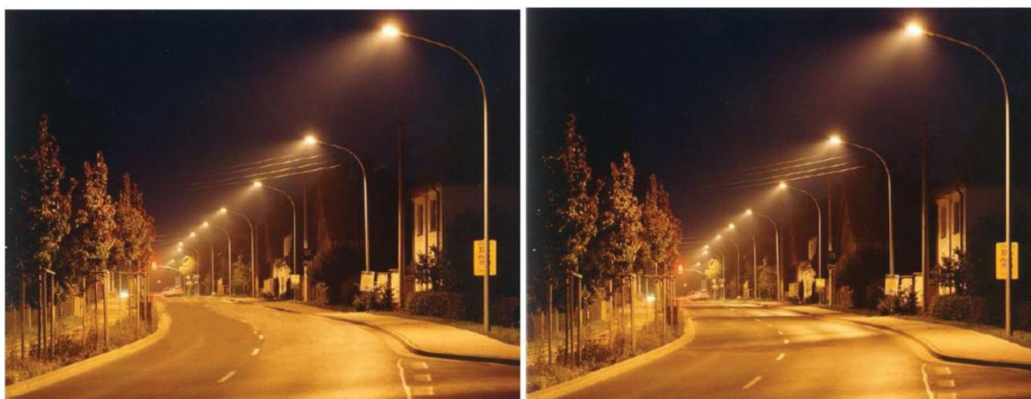
Εικόνα 6.12 Χαμηλή τιμή ολικής ομοιομορφίας (αριστερά) – Χαμηλή τιμή κατά μήκος ομοιομορφίας (δεξιά)
