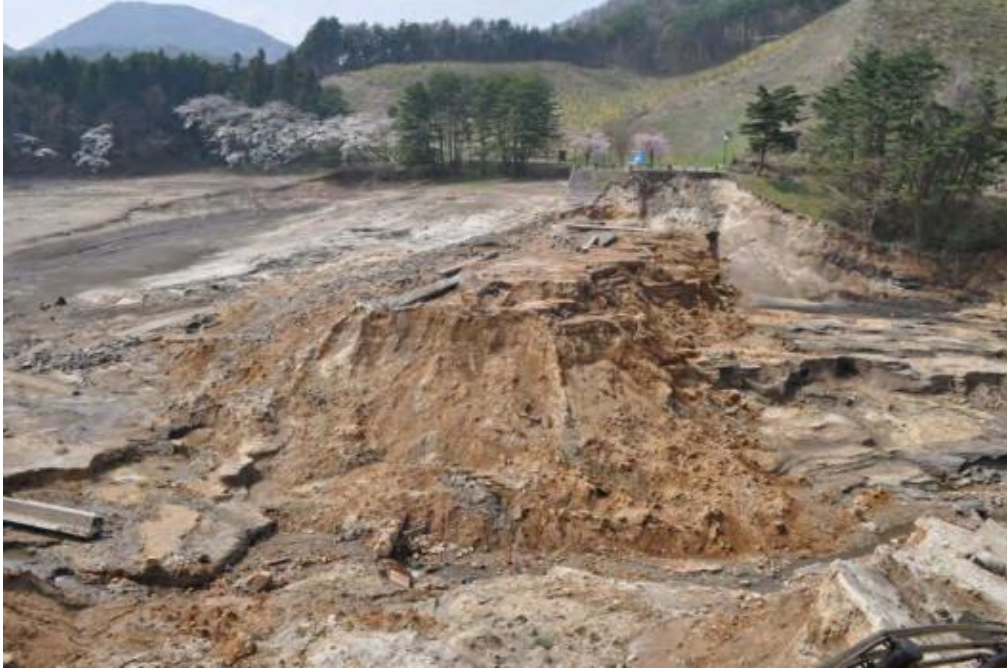
Εικόνα 2.29: Αστοχία που προκλήθηκε στον ταμιευτήρα του φράγματος (Πηγή: http://www.vncold.vn )
