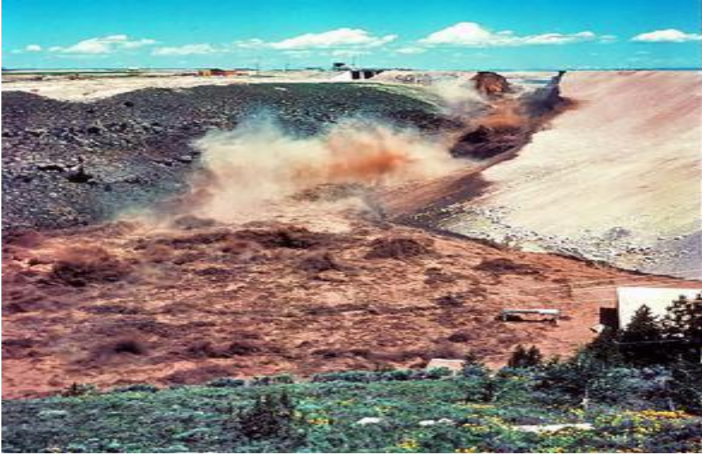
Εικόνα 2.24: Η εξέλιξη του φαινομένου της διασωλήνωσης (Πηγή: https://en.wikipedia.org )
