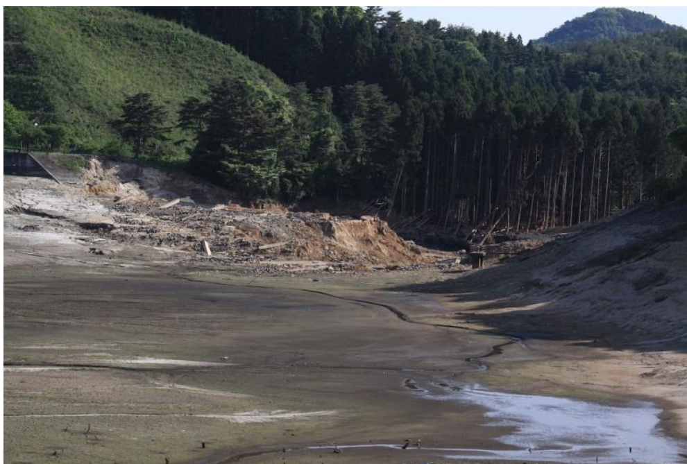
Εικόνα 2.28: Άδειος ταμιευτήρας φράγματος, μετά την αστοχία
