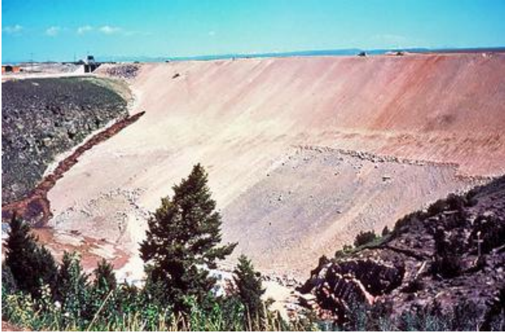
Εικόνα 2.22: Η εξέλιξη του φαινομένου της διασωλήνωσης (Πηγή: https://en.wikipedia.org )
