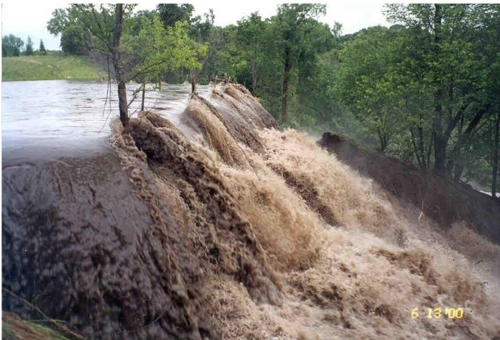
Εικόνα 2.13: Υπερχείλιση του ταμιευτήρα σε ένα πραγματικό φράγμα
