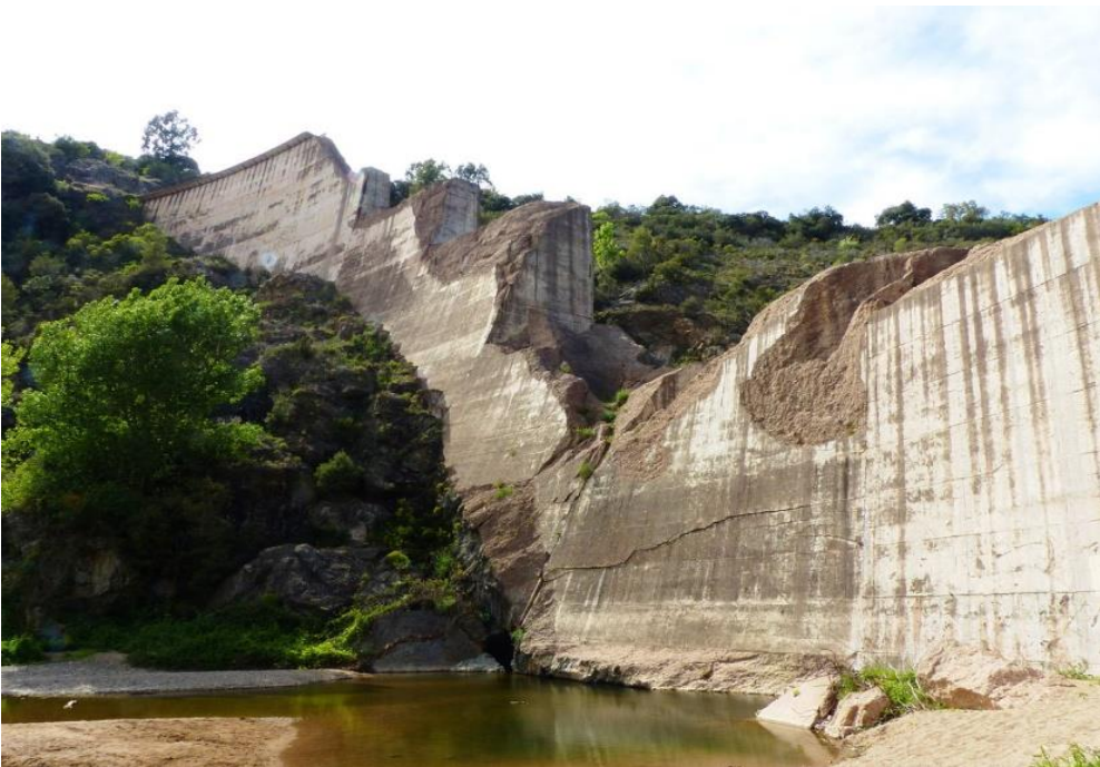
Εικόνα 2.21: Το φράγμα Malpasset μετά την αστοχία (Πηγή: https://en.wikipedia.org )
