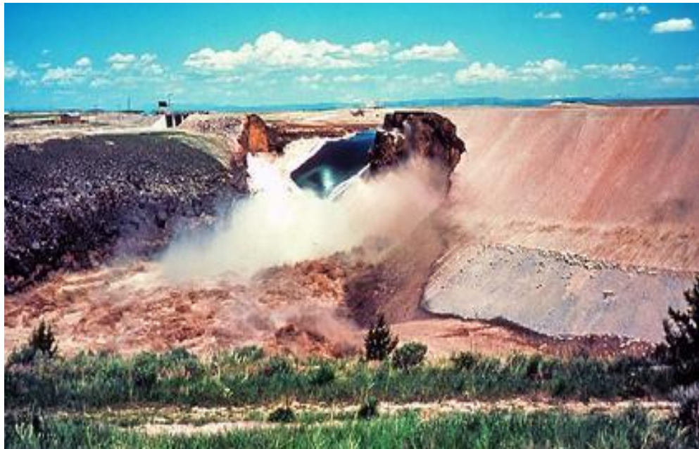
Εικόνα 2.25: Η εξέλιξη του φαινομένου της διασωλήνωσης (Πηγή: https://en.wikipedia.org )
