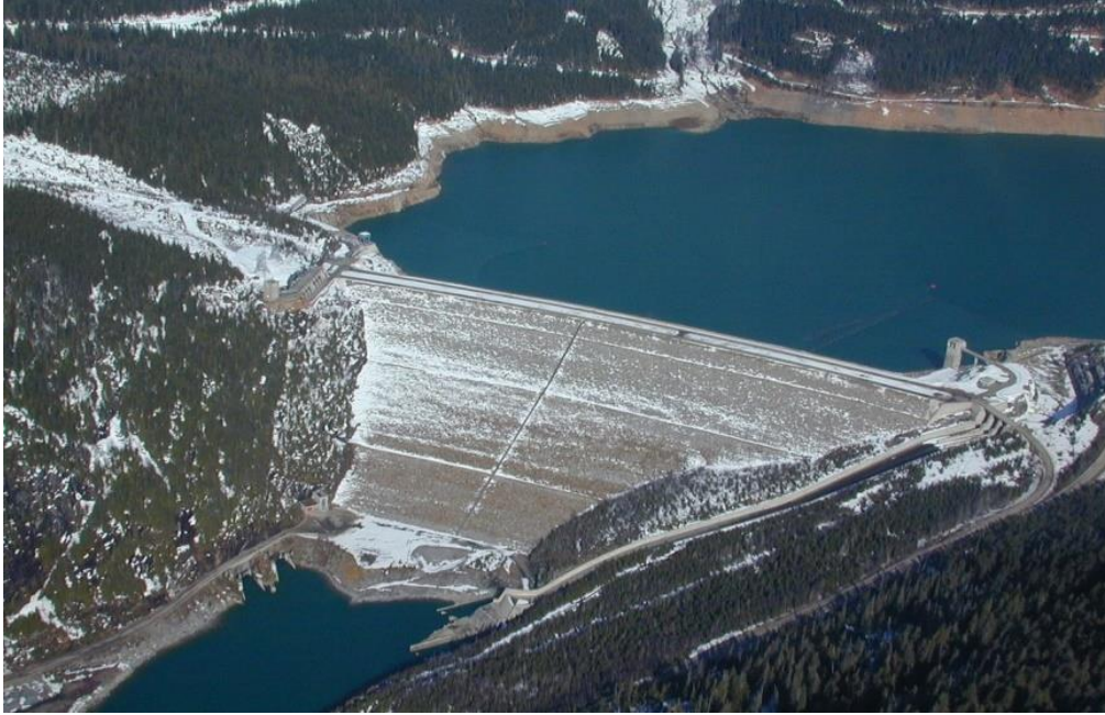
Εικόνα 2.8: Χωμάτινο φράγμα- Mica dam/Canada
