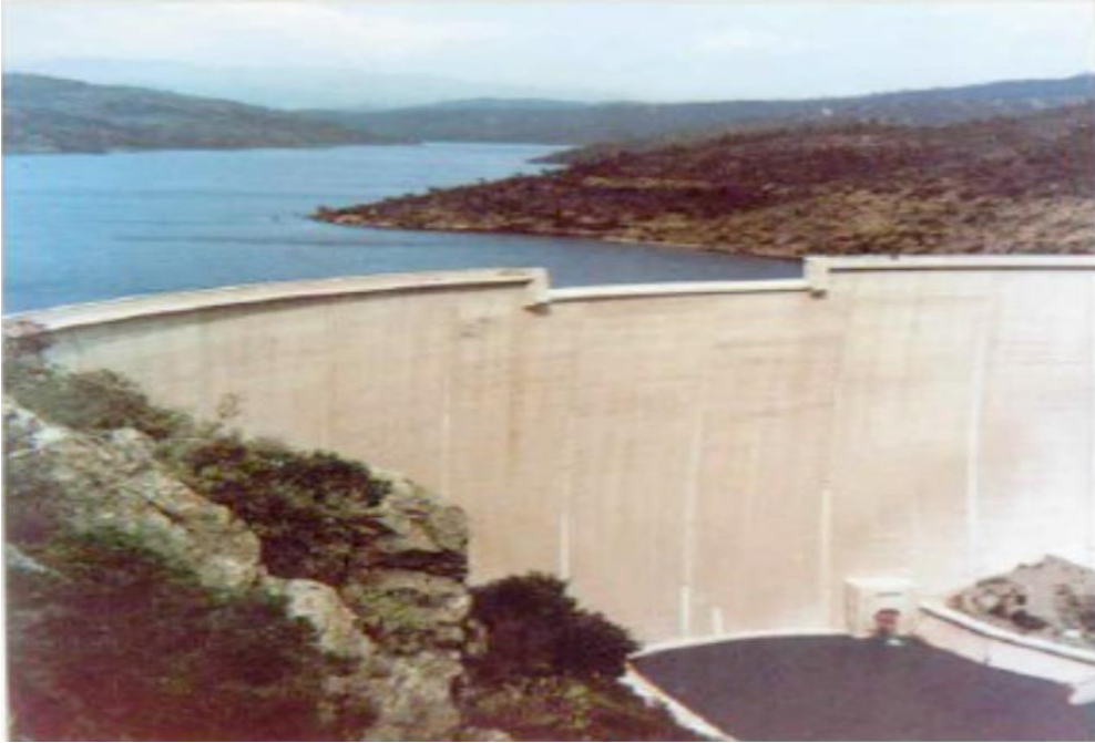
Εικόνα 2.20: Το φράγμα Malpasset πριν την αστοχία (Πηγή: http://damfailures.org )
