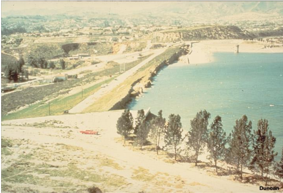
Εικόνα 2.34 : Γενική όψη του φράγματος San Fernando, στην οποία φαίνεται η ολίσθηση στο ανάκτιο πρανές
