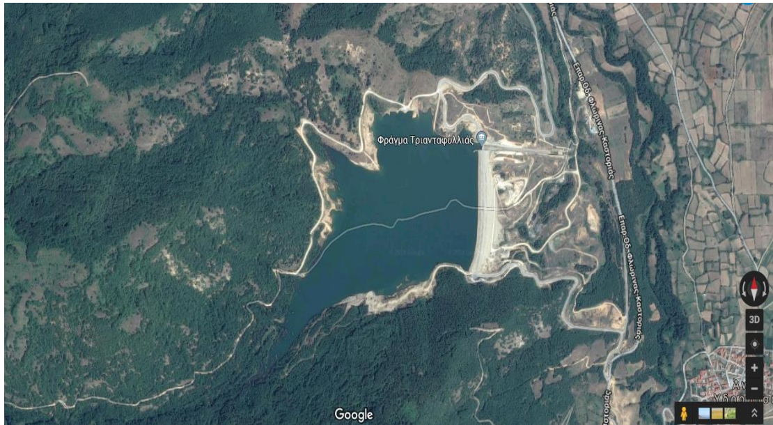
Εικόνα 4.3: Δορυφορική φωτογραφία που δείχνει το φράγμα της Τριανταφυλλιάς σε κάτοψη (Πηγή: Google Maps)
