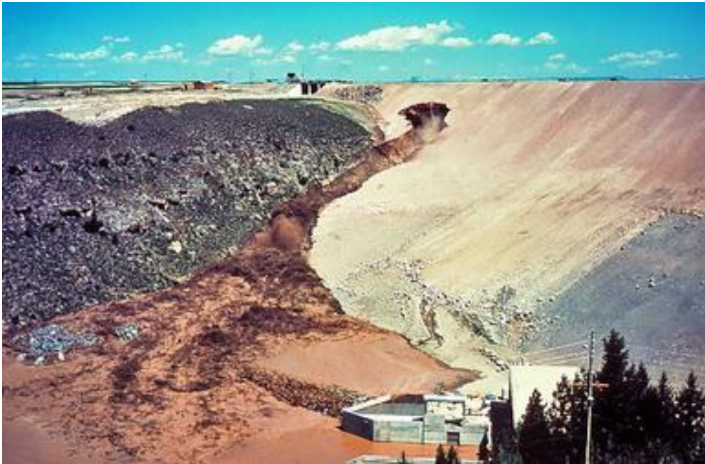
Εικόνα 2.23: Η εξέλιξη του φαινομένου της διασωλήνωσης (Πηγή: https://en.wikipedia.org )
