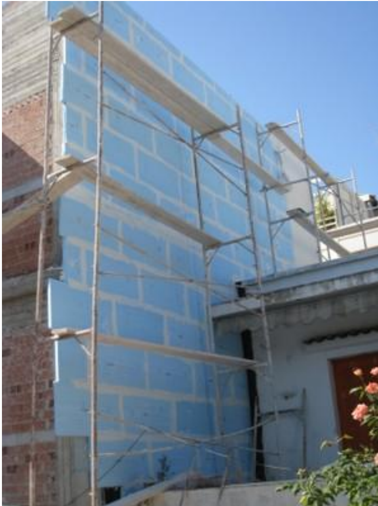
Εικόνα 2.8-2: Φωτογραφία που λήφθηκε κατά τη διάρκεια εφαρμογής εξωτερικής θερμομόνωσης
