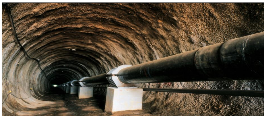
Εικόνα 2.4: Κατασκευαζόμενη σήραγγα και αγωγός του έργου Minas-Rio (Πηγή: ausenco.com)
