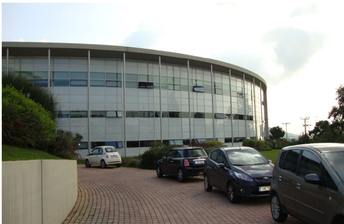
Εικόνα 3.1: Άποψη της μπροστινής πλευράς του κτιρίου των ΚΑΕ
