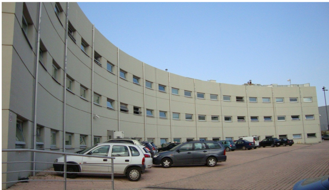
Εικόνα 3.2: Άποψη της πίσω πλευράς του κτιρίου των ΚΑΕ
