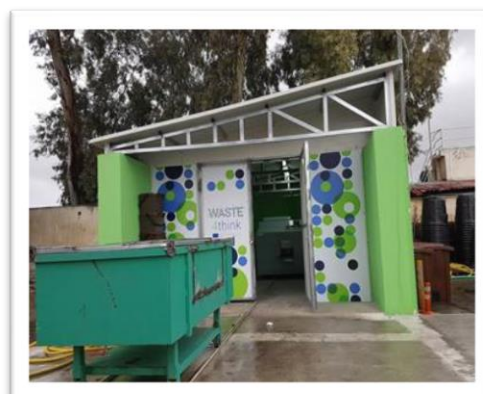
Εικόνα 21 : Μονάδα επεξεργασίας δήμου Χαλανδρίου
