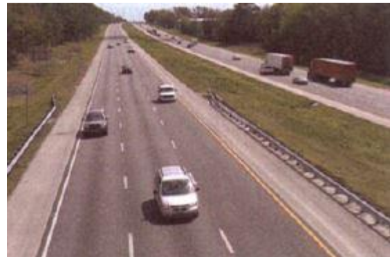
ΣΤΑΘΜΗ ΕΞΥΠΗΡΕΤΗΣΗΣ Β
