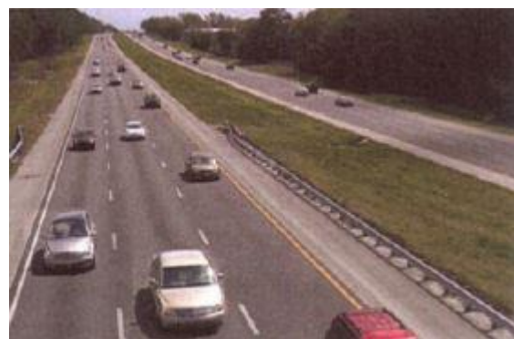
ΣΤΑΘΜΗ ΕΞΥΠΗΡΕΤΗΣΗΣ D
