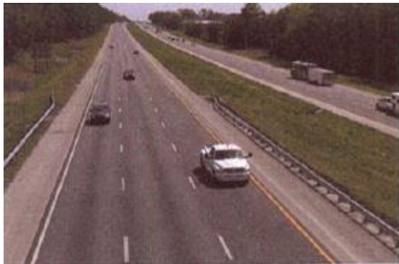
ΣΤΑΘΜΗ ΕΞΥΠΗΡΕΤΗΣΗΣ Α
