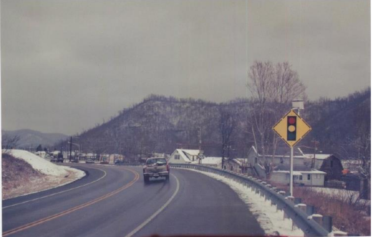
Εικόνα 3.8 LED signal ahead warning sign
