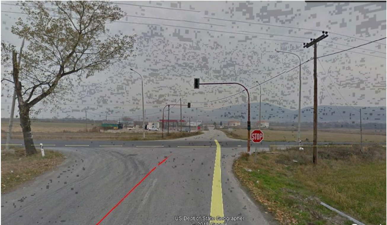
Εικόνα 4.5 Κόμβος 38-39 επαρχιακού οδικού άξονα 12 της Φλώρινας[Πηγή: Google Earth]
