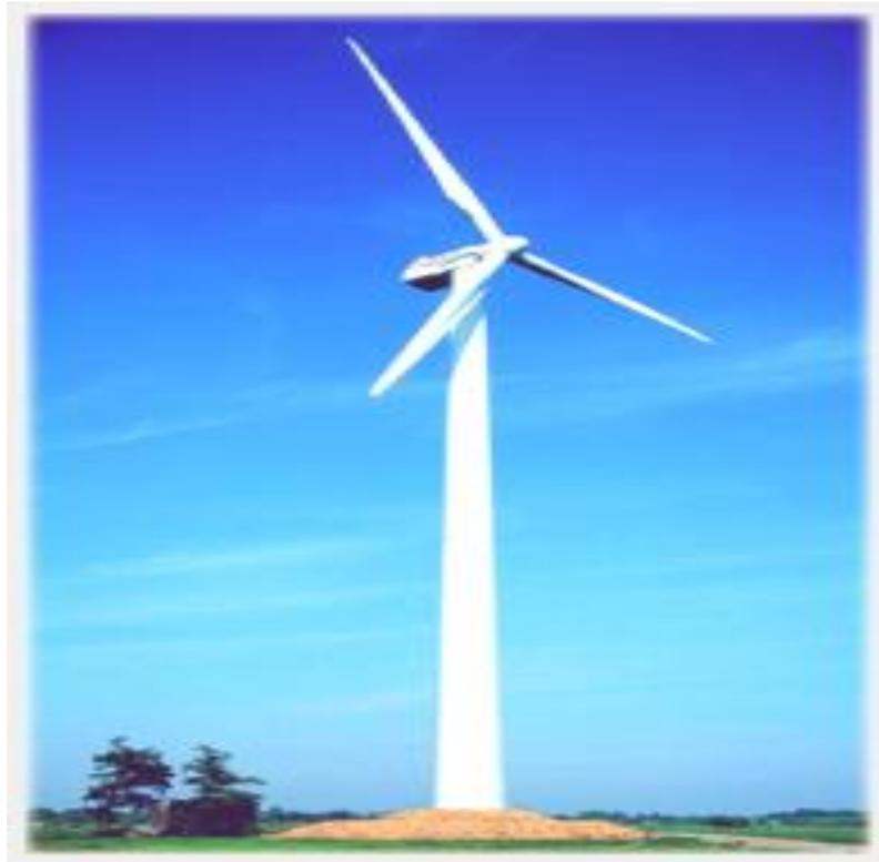
Εικόνα 4 Ανεμογεννήτρια Οριζοντίου Άξονα<sup>4</sup>
