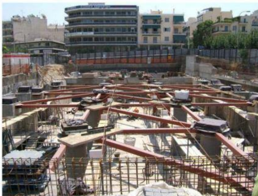
Εικόνα 4.1 Στέγη Γραμμάτων και Τεχνών , Ίδρυμα Ωνάση στην φάση κατασκευής του ,τοποθέτηση εφεδράνων
