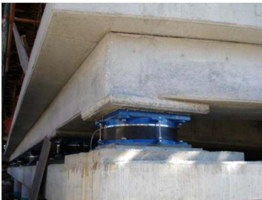
Εικόνα 4.5 Μουσείο της Ακρόπολης στη φάση κατασκευής , λεπτομέρεια εφεδράνου
