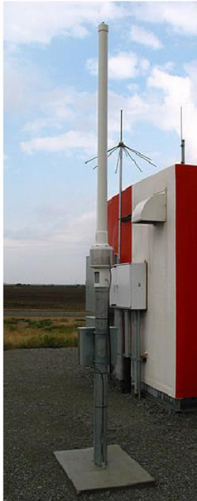
Εικόνα 2.7: Αναμεταδότης DME εδάφους στο αεροδρόμιο της Στουτγκάρδης (αριστερά) και ανακριτής DME εντός αεροσκάφους (δεξιά)
