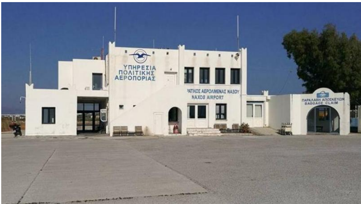
Εικόνα 4.13: Αεροσταθμός κρατικού αερολιμένα Νάξου
