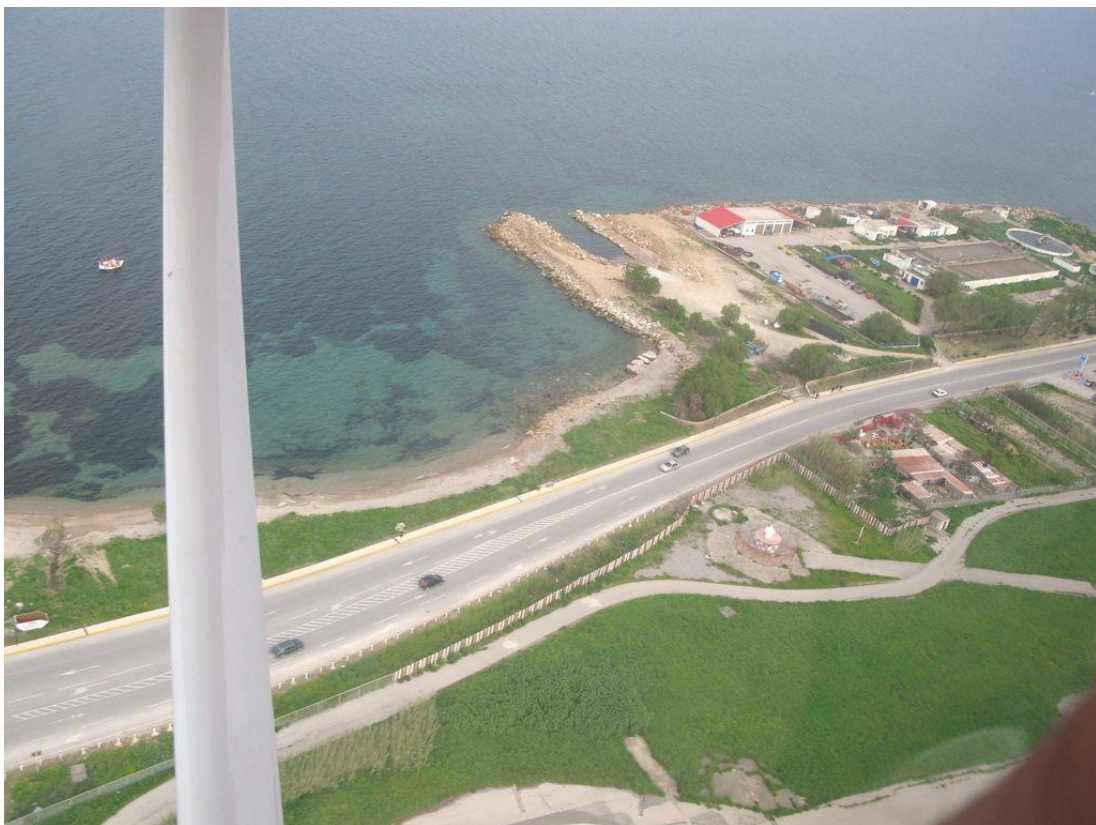
Εικόνα 4.6: Φωτογραφία-όψη του ραδιοβοηθήματος από ψηλά
