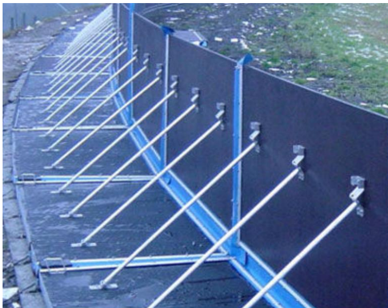
Εικόνα 21: Aqua Fence. (Πηγή: Port of Long Beach & AECOM, 2016)
