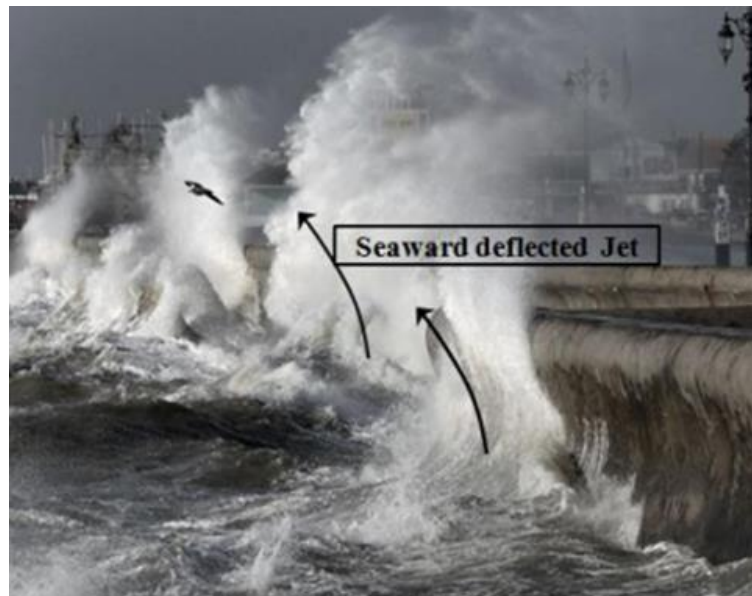
Εικόνα 12: Καμπύλος προφυλακτήριος τοίχος σε κυματοθραύστη με κατακόρυφο μέτωπο. (Πηγή: www.alamy.com , 2016)
