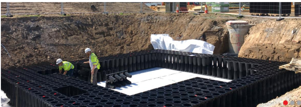
Εικόνα 31: Δεξαμενή συγκράτησης ACO StormBrixx®. (Πηγή: www.aco.co.uk , 2019)
