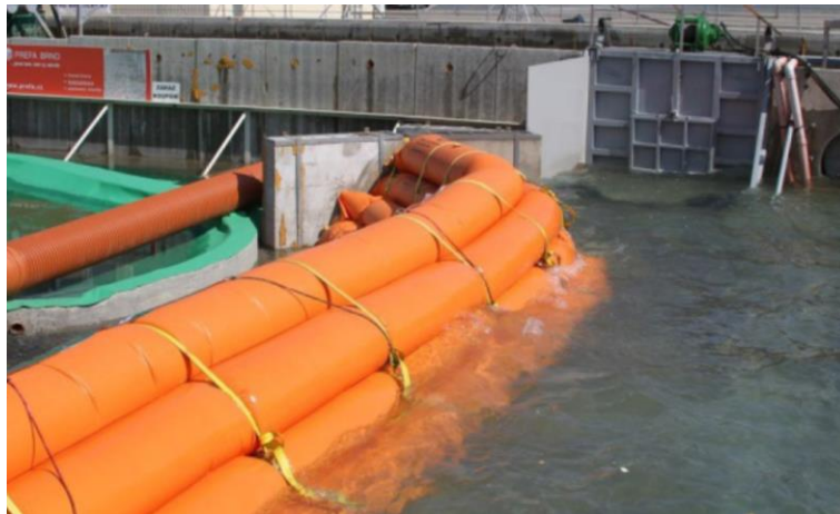
Εικόνα 23: Tiger Dam. (Πηγή: Port of Long Beach & AECOM, 2016)
