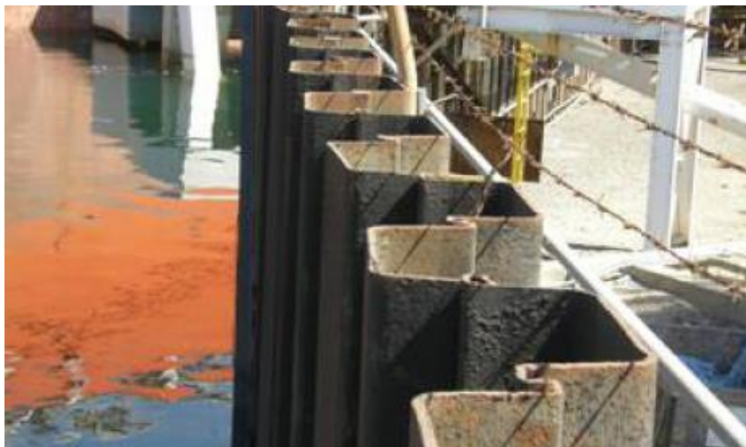
Εικόνα 27: Τοίχος από πασσαλοσανίδες. (Πηγή: Port of Long Beach & AECOM, 2016)
