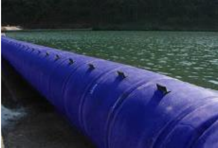
Εικόνα 26: Φράγμα από καουτσούκ. (Πηγή: Port of Long Beach & AECOM, 2016)
