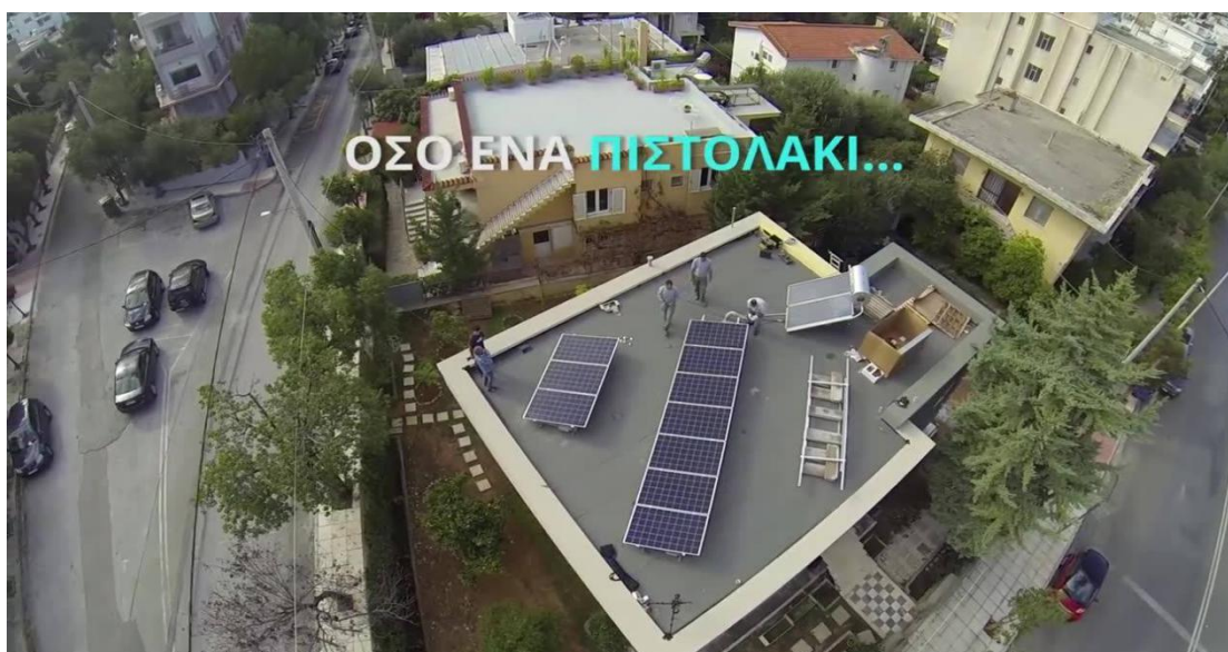
Εικόνα 5.58: Εικόνα τοποθέτησης Φ/Β συστήματος σε ανακαίνιση ΠΚ, το οποίο καταναλώνει όση ενέργεια καταναλώνει ένα πιστολάκι μαλλιών. [65]
