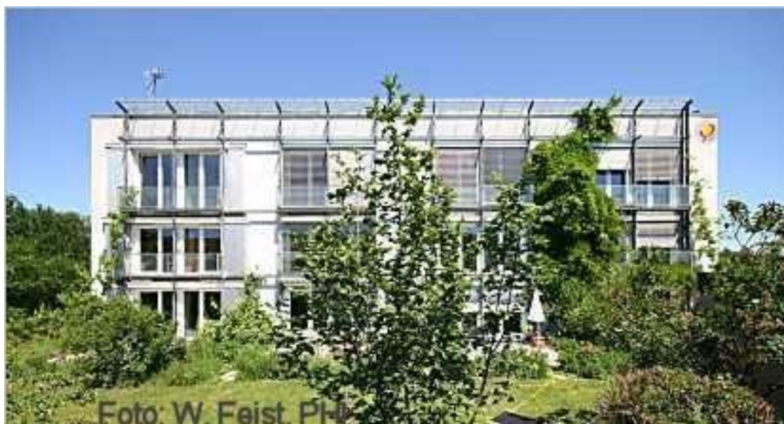
Εικόνα 4.4: Το πρώτο πιστοποιημένο παθητικό κτίριο στο Darmstadt [9]
