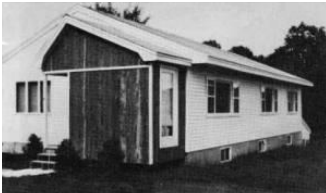
Εικόνα 4.3: Παράδειγμα από εξαιρετικά μονωμένο κτίριο στη Βόρειο Αμερική [9]
