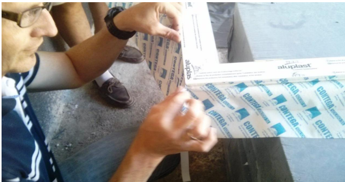
Εικόνα 5.43: Ειδικές αεροστεγείς ταινίες, οι οποίες τοποθετούνται περιμετρικά των κουφωμάτων, πριν αυτά τοποθετηθούν [65]
