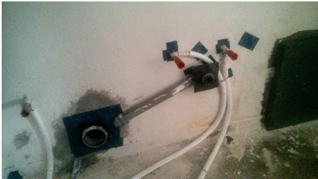
Εικόνα 5.41: Ειδικά κολάρα, τοποθετημένα σε σπές στους τοίχους [65]
