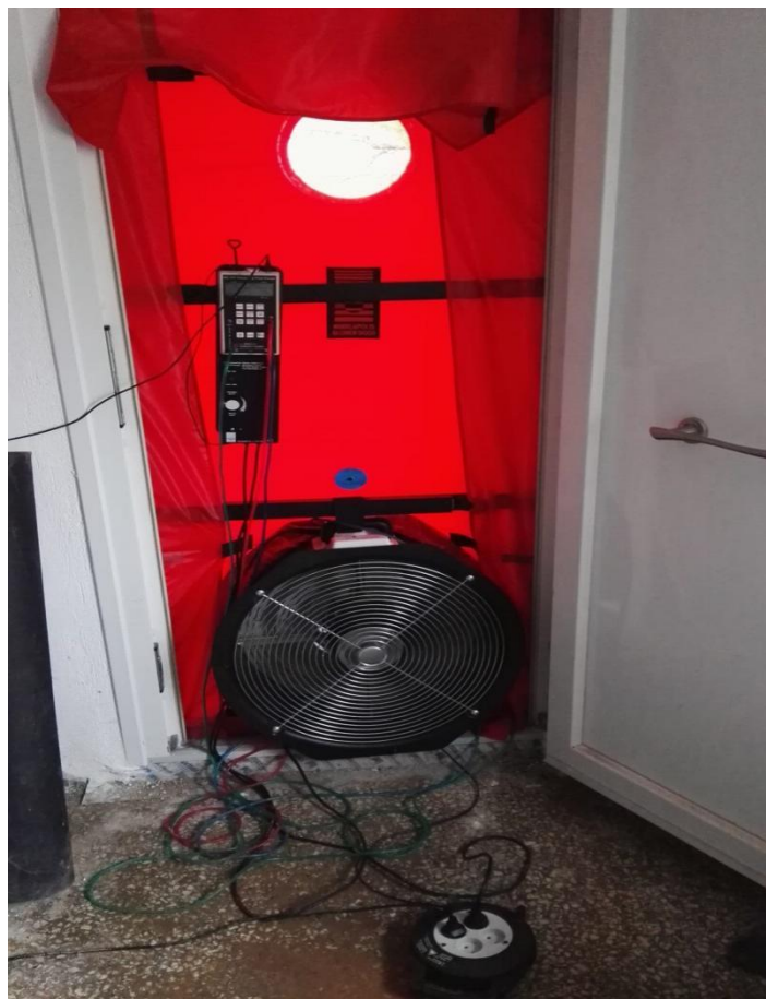
Εικόνα 5.44: Παράδειγμα χρήσης του τεστ αεροστεγανότητας σε ανακαίνιση και ενεργειακή αναβάθμιση κτιρίου [65]
