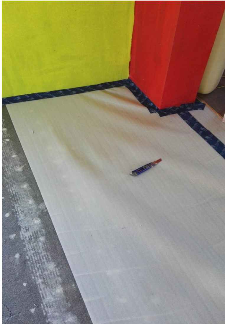
Εικόνα 5.42: Η αεροστεγανότητα κλείνει στο επίπεδο του δαπέδου το θερμικό φάκελο [65]
