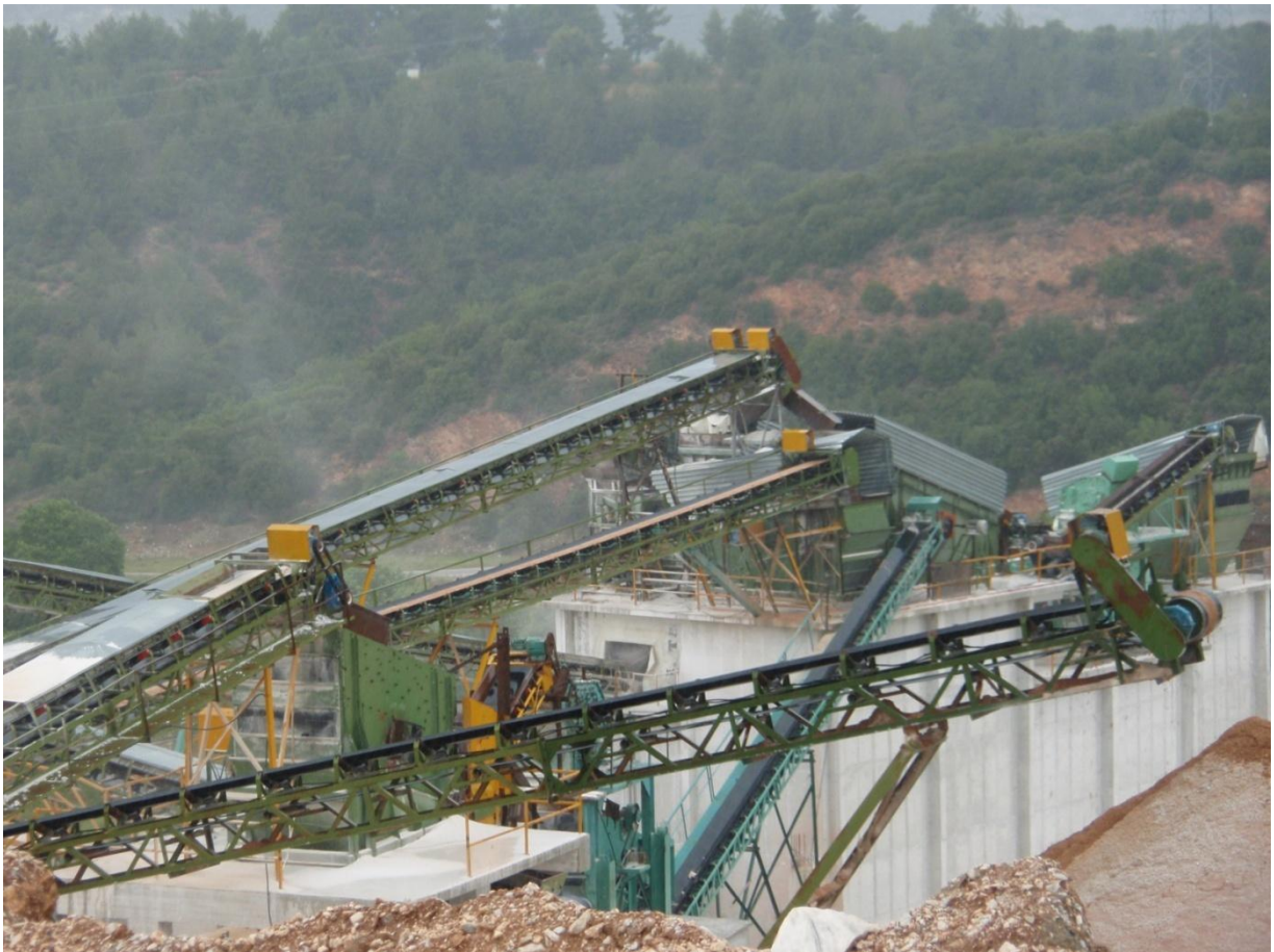
Εικόνα 5.6: Συγκρότημα επεξεργασίας εξορυγμένου υλικού
