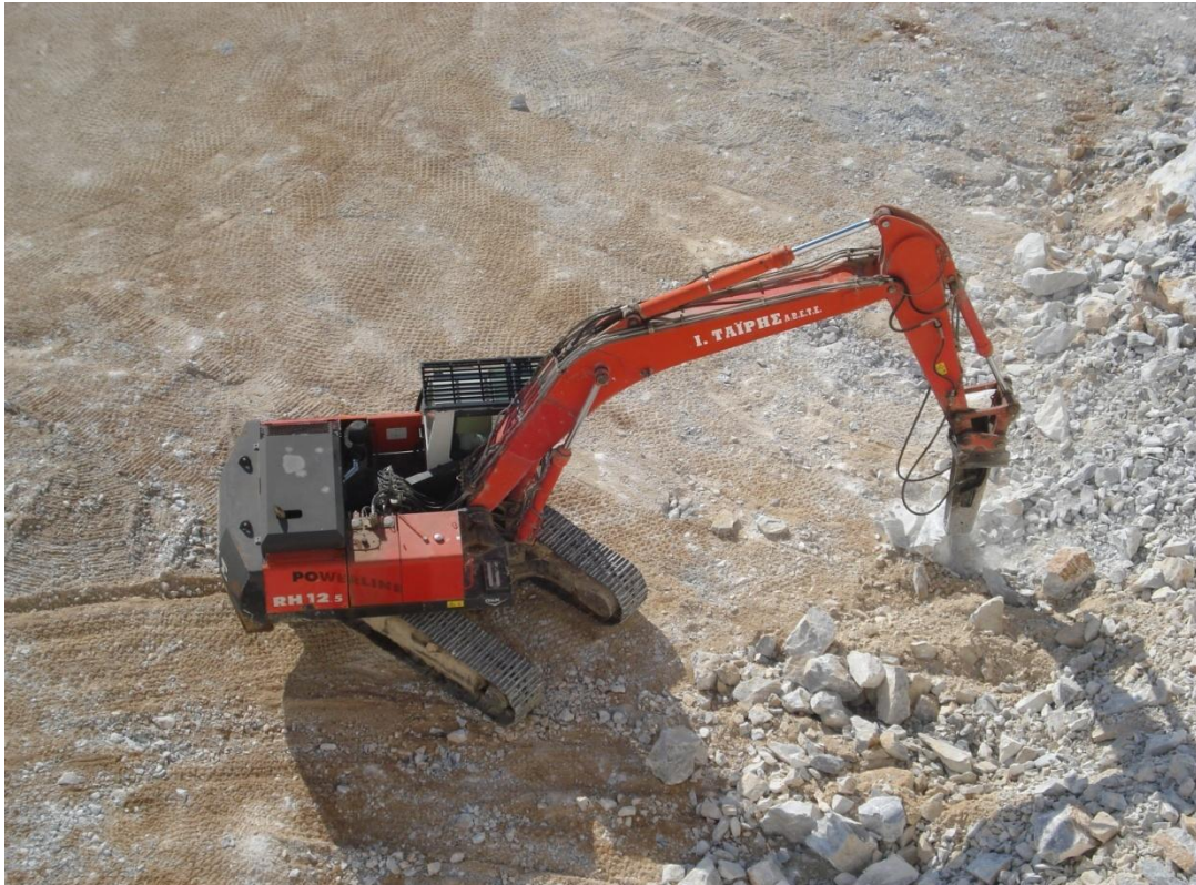
Εικόνα 5.3: Εξόρυξη με μηχανικά μέσα
