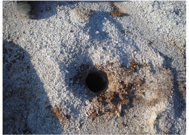
Εικόνα 5.1. Εργασίες διάτρησης υπονόμων
