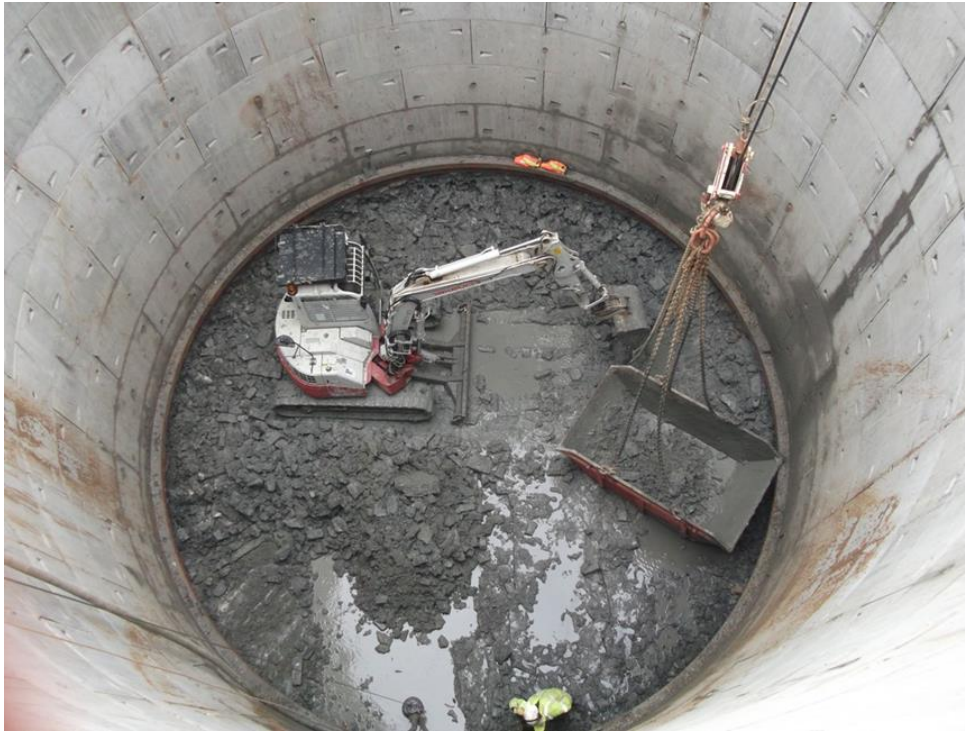
Σχήμα 38. Παράλληλη εκσκαφή και αποκομιδή σε κυκλικό φρέαρ.
