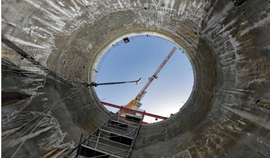
Σχήμα 35.Όψη φρέατος από το εσωτερικό (Φρέαρ Ρολόι σταθμού Πειραιά μετρό Αθήνας)
