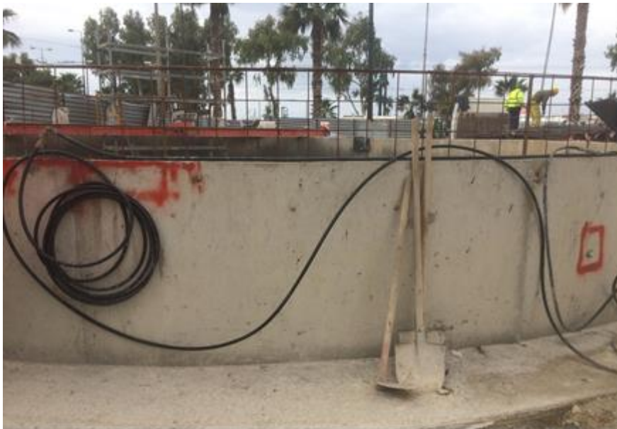
Σχήμα 37.Κολάρο ασφαλείας φρέατος (Φρέαρ Ρολόι σταθμού Πειραιά μετρό Αθήνας)
