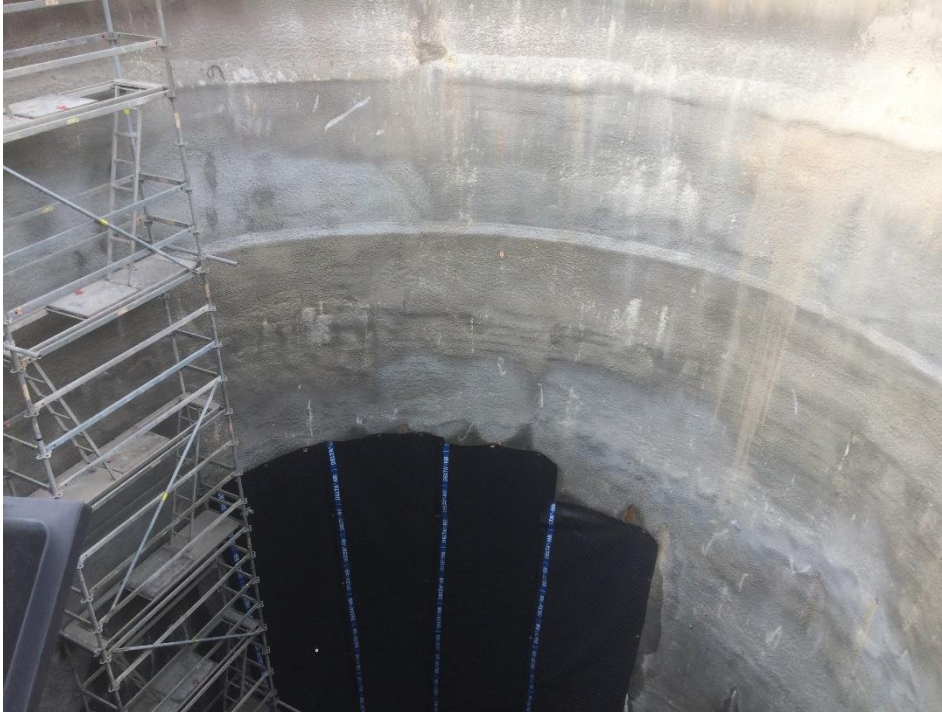
Σχήμα 43. Τοποθέτηση μεμβράνης στεγανοποίησης
