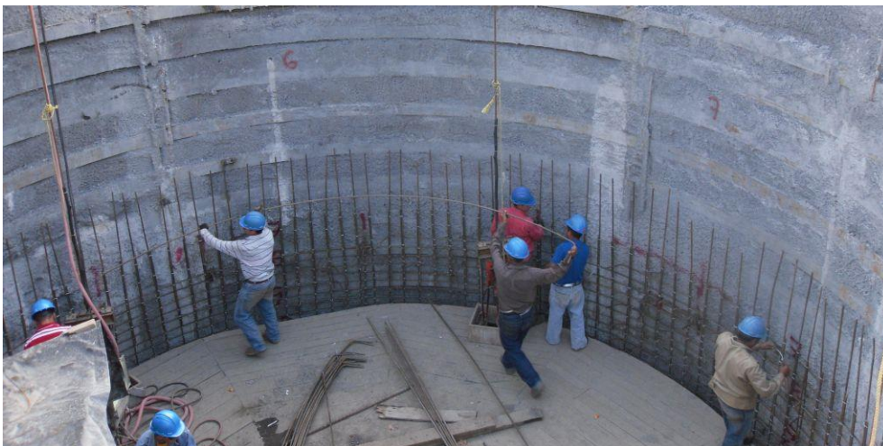
Σχήμα 44. Σκυροδέτηση τελικής επένδυσης φρέατος
