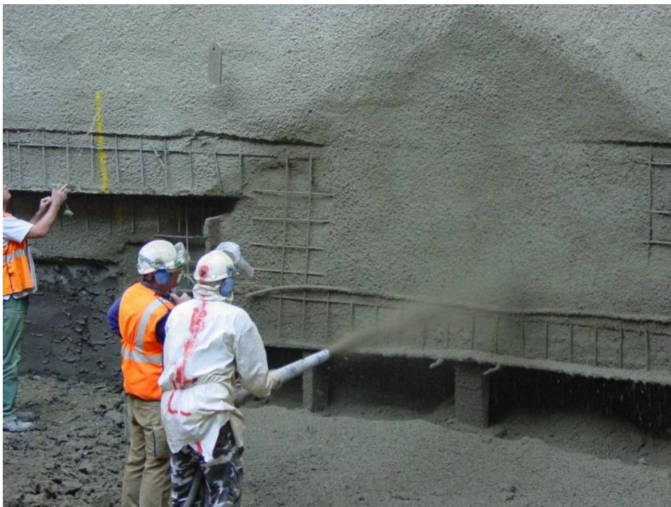
Σχήμα 41. Ψεκασμός τελικής στρώσης σκυροδέματος
