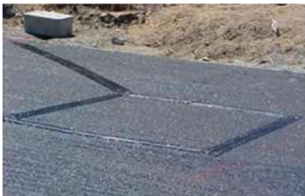
Εικόνα 4. 5: Απλός επαγωγικός βρόχος μετά την εγκατάσταση
