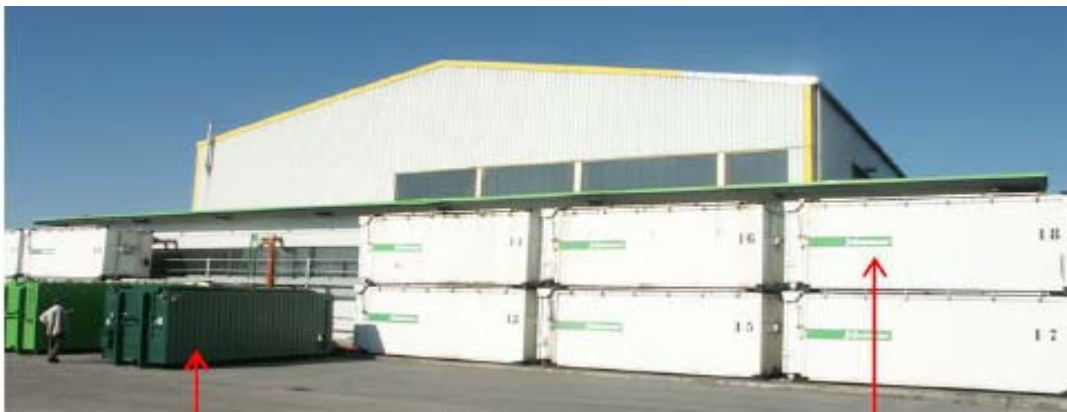
Εικόνα 7.3: Κουτιά της γερμανικής εταιρίας Nehlsen (Αριστερά: νεότερα Κουτιά προστίθενται – Δεξιά: αρχικά Κουτιά στην εγκατάσταση [9])
