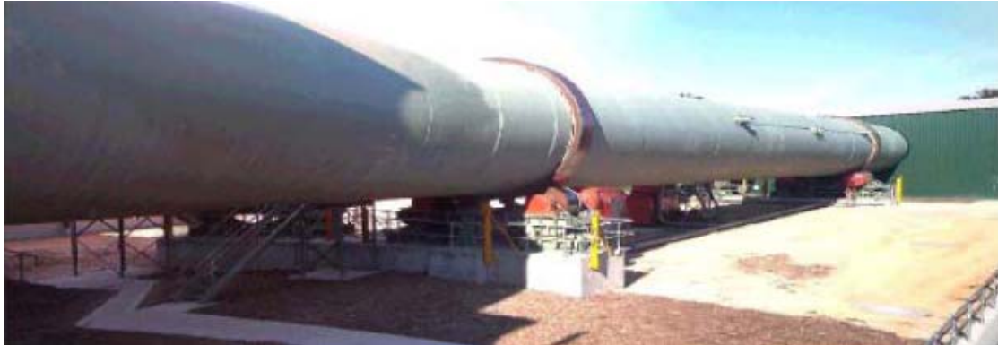
Εικόνα 3.9: Σύστημα κομποστοποίησης σε περιστρεφόμενο τύμπανο της εταιρίας Bedminster (χρόνος παραμονής 3 ημέρες)
