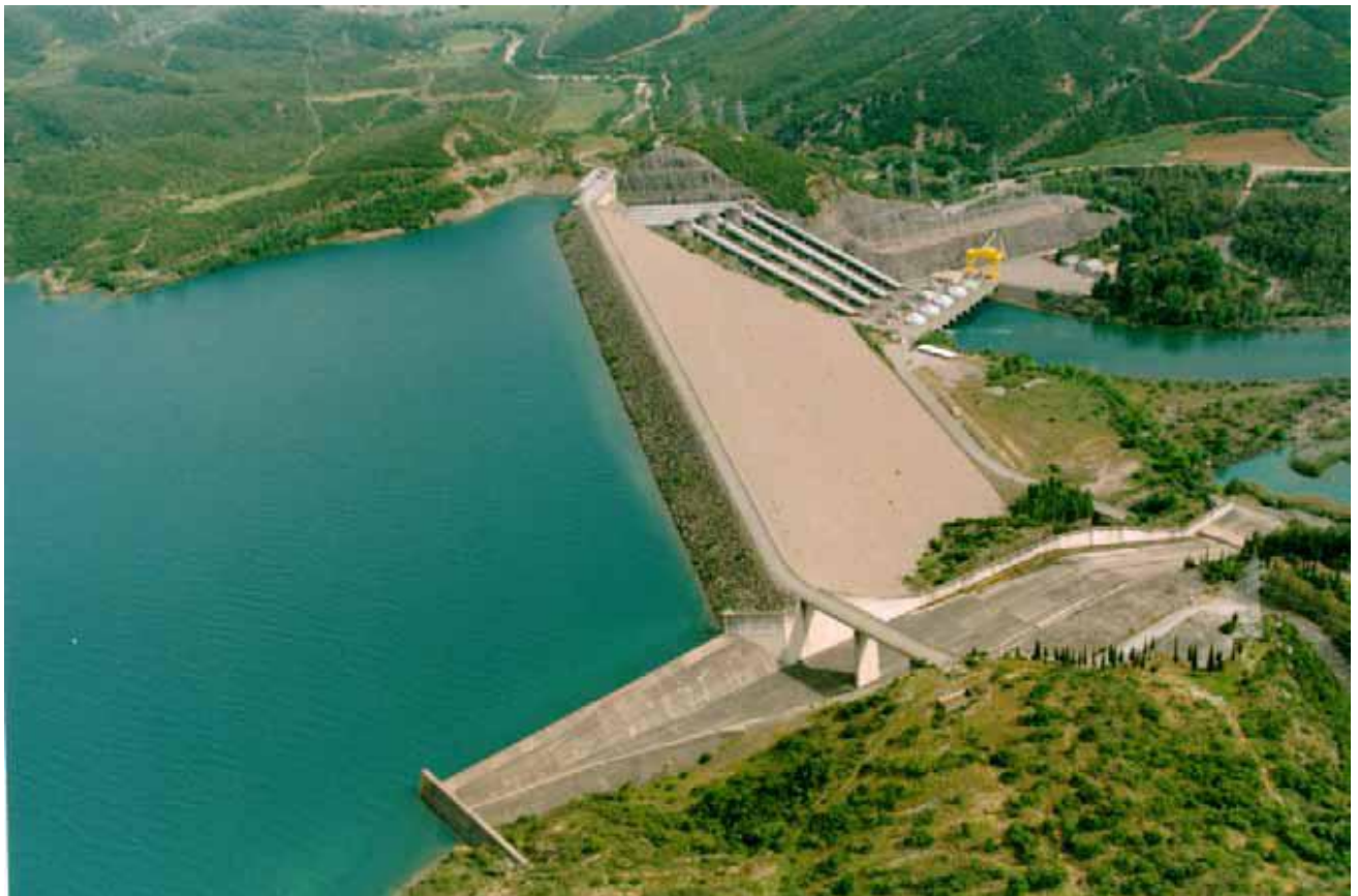
Εικόνα 5.2 Υδροηλεκτρικό έργο Καστρακίου-Στράτου
