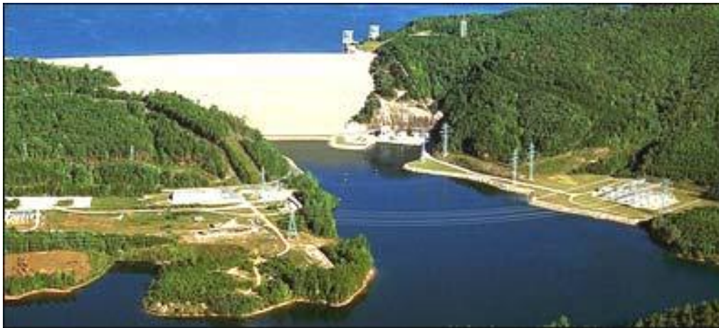
Σύστημα αντλησιοταμίευσης ονομαστικής ισχύος 612 MW στο Salem της Νότιας Καρολίνας, Η.Π.Α.
