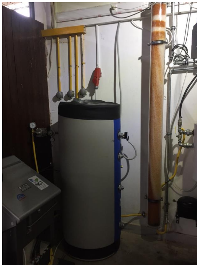
Εικόνα 32 Στήλη απομάκρυνσης υγρασίας και συμπιεστής της πιλοτικής εγκατάστασης
