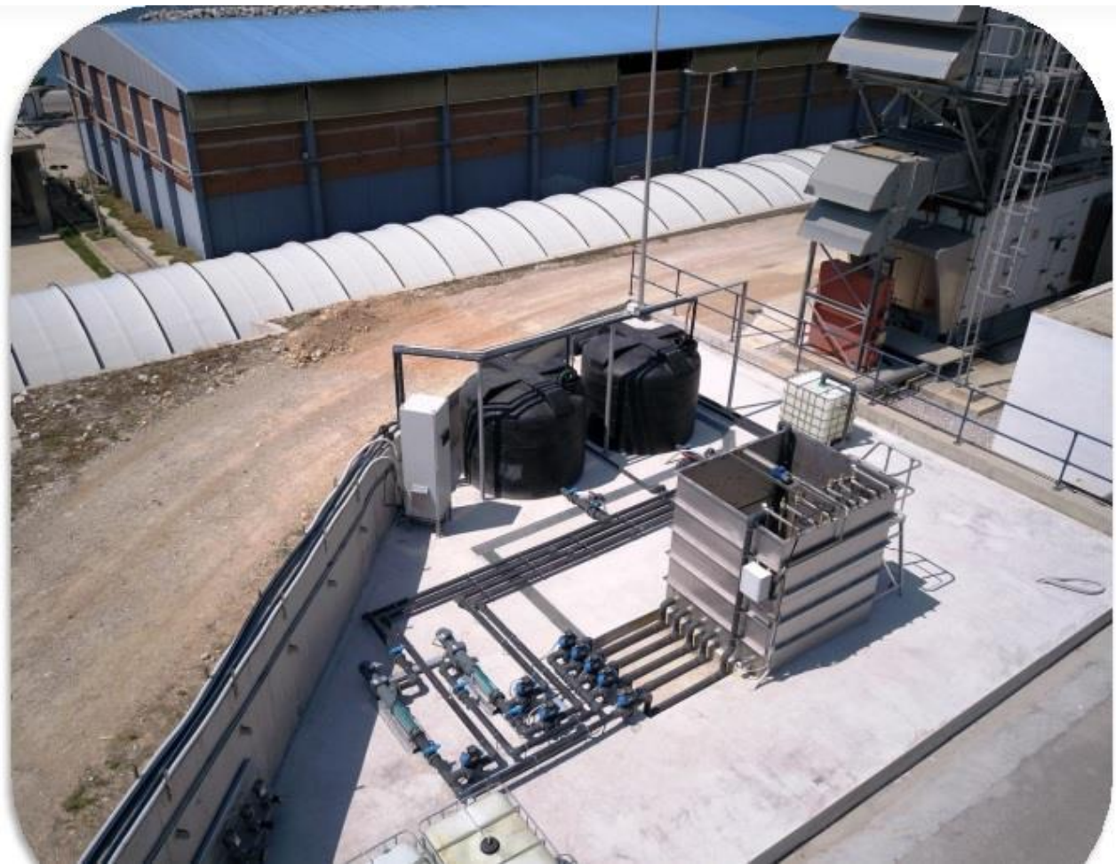
Εικόνα 1: Εγκατάσταση αντιδραστήρα SBR πιλοτικού προγράμματος στην Ψυττάλεια.
