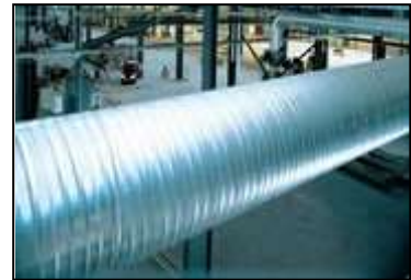
Εικόνα 6.1 Σπειρωτοί - Γαλβανιζέ σωλήνες (12)
