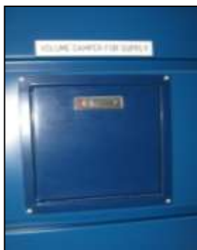
Εικόνα 4.1 Δίοδος παροχής αέρα στη γέφυρα του πλοίου (*)
