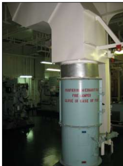
Εικόνα 4.14 Διάταξη Ανεμιστήρας με αγωγό κυκλοφορίας του αέρα (*)
