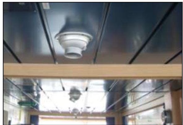
Εικόνα 4.3 Διαχύτης τύπου punkah (*)
