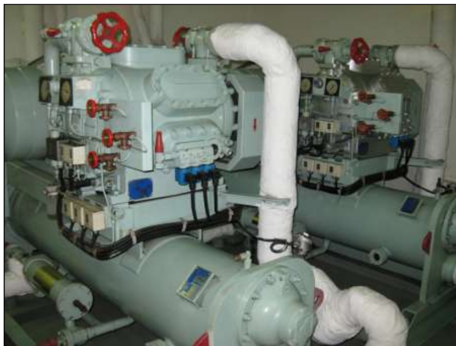
Εικόνα 6.10 Μονάδα συμπύκνωσης κλιματιστικής εγκατάστασης (δύο ίδιες μονάδες μια για κάθε AHU) (*)
