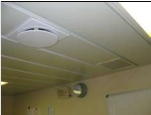
Εικόνα 4.2 Θολωτός διαχύτης αέρα (*)
