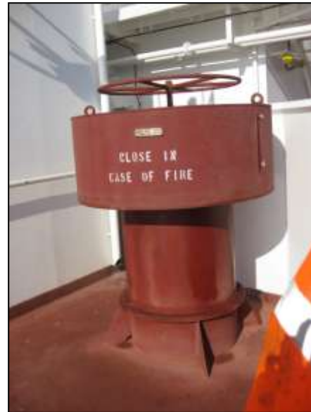
Εικόνα 4.6 Ανεμιστήρας τύπου μανιτάρι για αερισμό του χώρου πηδαλίου (* )
