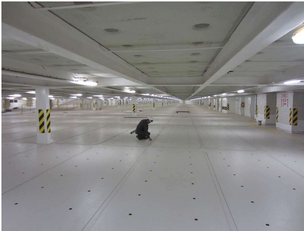
Σχήμα 1.3: Τελική κατασκευή καταστώματος αυτοκινήτων
