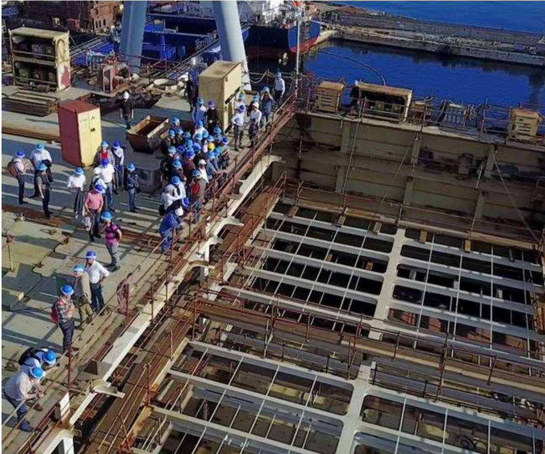
Σχήμα 1.2: Χαλύβδινος σκελετός καταστώματος αυτοκινήτων
