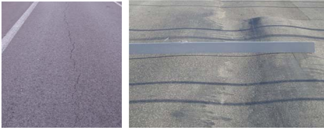
Εικόνα 2.6: Ρηγμάτωση και Τροχοαυλάκωση ασφαλτομίγματος
