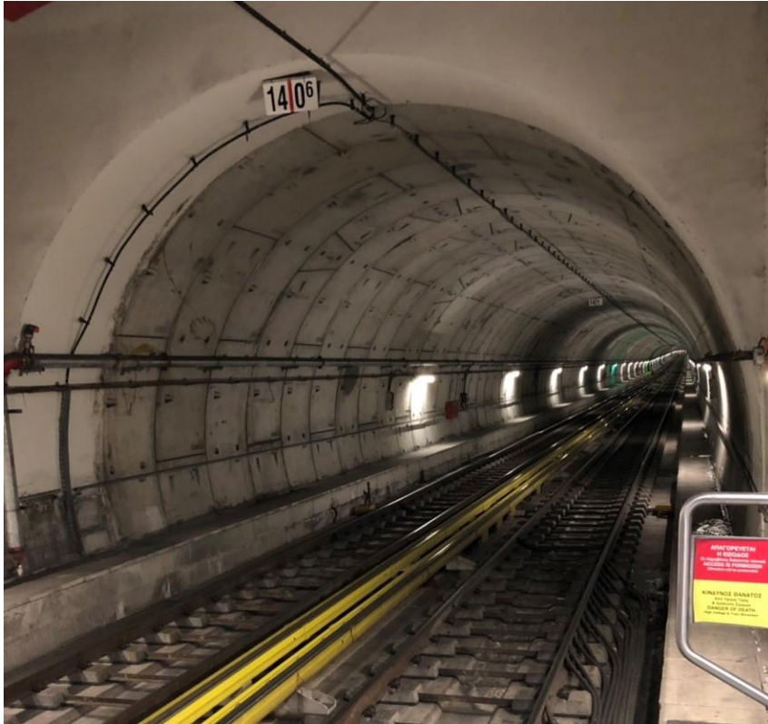
Εικ.1.2 : Σήραγγα TBM από τον Σταθμό Αργυρούπολη με Κατεύθυνση τον Σταθμό Ελληνικό
