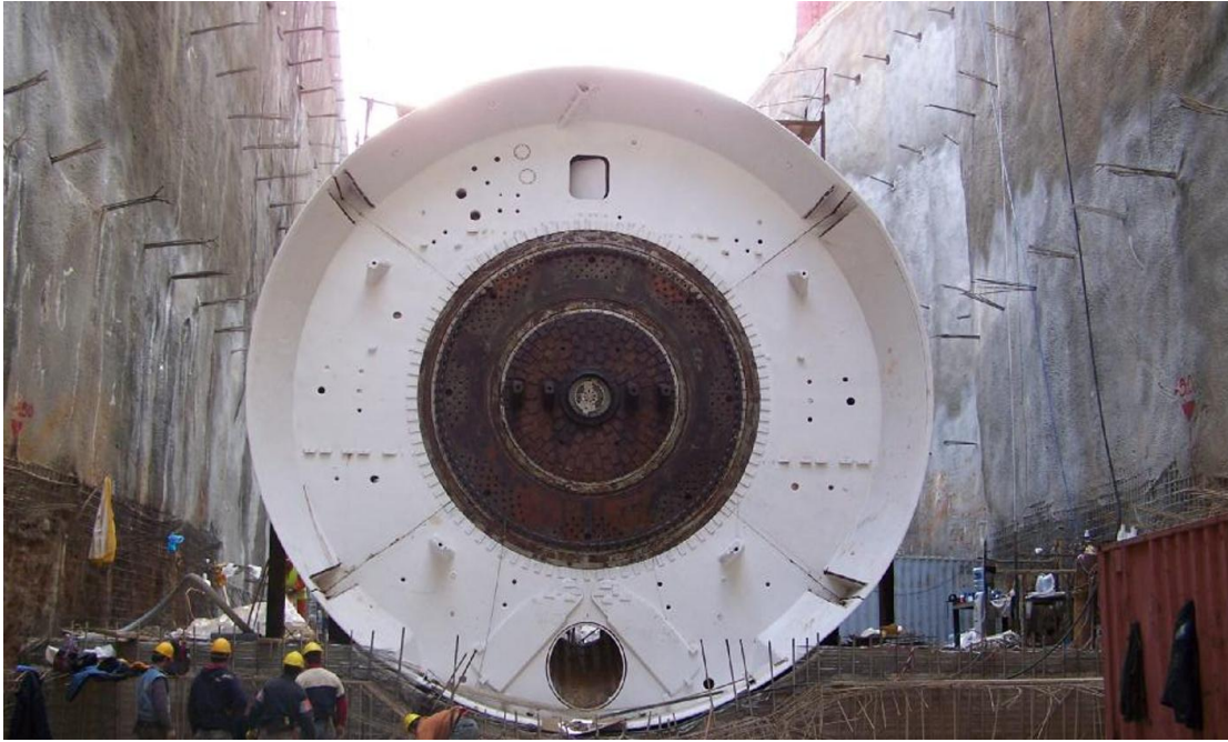
Εικ.2.9: Κύριο Εφέδρανο της Μηχανής EPB του Μετρό προς Ελληνικό (ΑΤΤΙΚΟ ΜΕΤΡΟ Α.Ε.)
