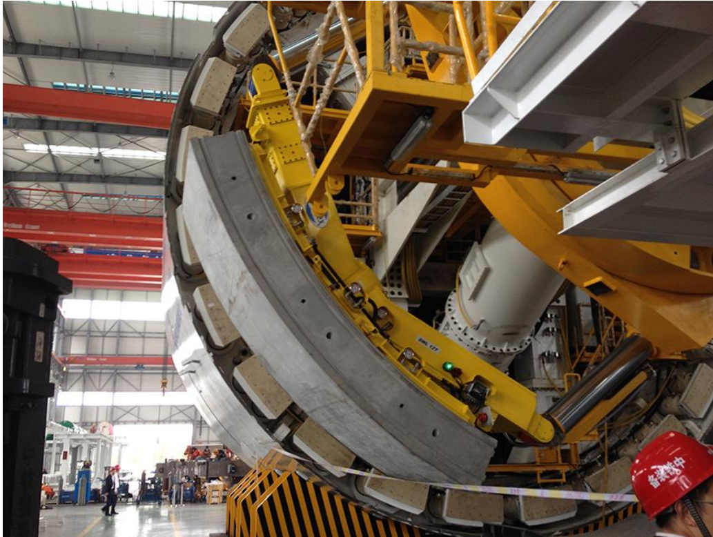
Εικ.2.10 : Δοκιμή Ανύψωσης Δακτυλίου Σκυροδέματος στην Θέση Τοποθέτησης (CBE Group, 2019)
